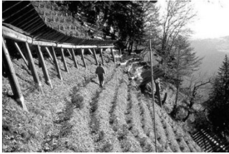
Abbildung 2: Bermentrittanlage mit Jungpflanzung (SLF Versuchsanlage Bleisa/Pusserein, Schiers GR (Leuenberger 2003)).
