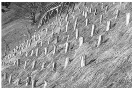
Abbildung 1: Pfählung auf einem grasbewachsenen Hang (SLF Versuchsanlage Bleisa/Pusserein, Schiers GR (Leuenberger 2003)).
