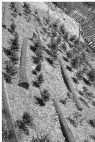
Abbildung 3: Hang mit Schwellen und junger Aufforstung (SLF Versuchsanlage Bleisa/Pusserein, Schiers GR (Leuenberger 2003)).
