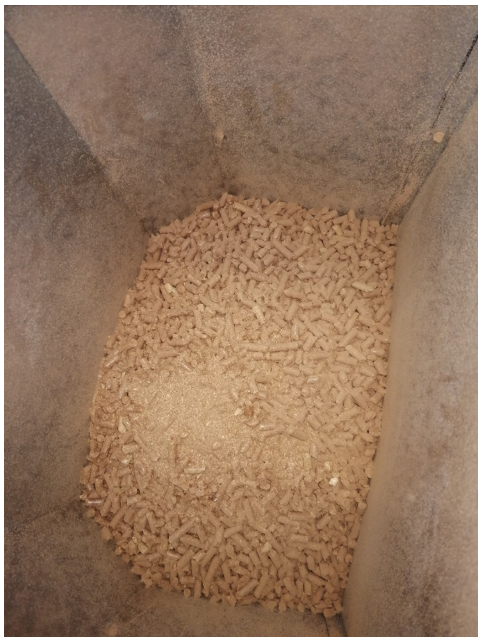
Vue de l'accumulateur qui alimente le poêle en pellets. Photo : FHNW
