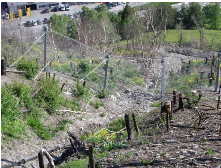
Abbildung 79: Murgangnetze, errichtet nach dem Waldbrand in Visp 2011 (Foto: Schwarz M.).
