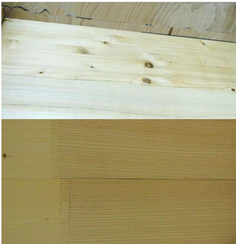
Abbildung 82: Rissbildung bei Hybridelementen Fichte/Esche.
