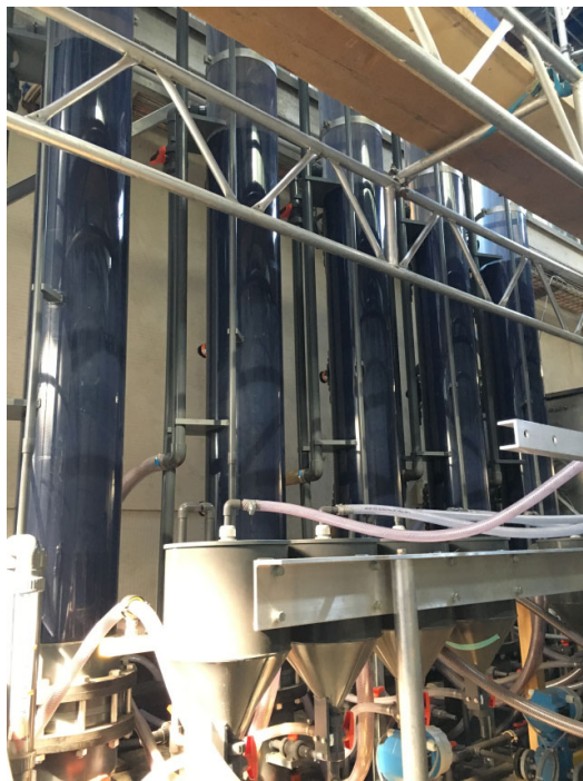
Bild: GAK-Kolonnen auf ARA Glarnerland (links), GAK Filter auf ARA Altenrhein (rechts oben), PAK-Zudosierung auf ARA ProReno (rechts unten)
