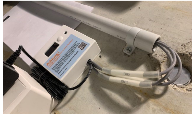
Abbildung 40: Anschluss der Sensorbänder 1, 2 und 4 an die Auswertereinheit
