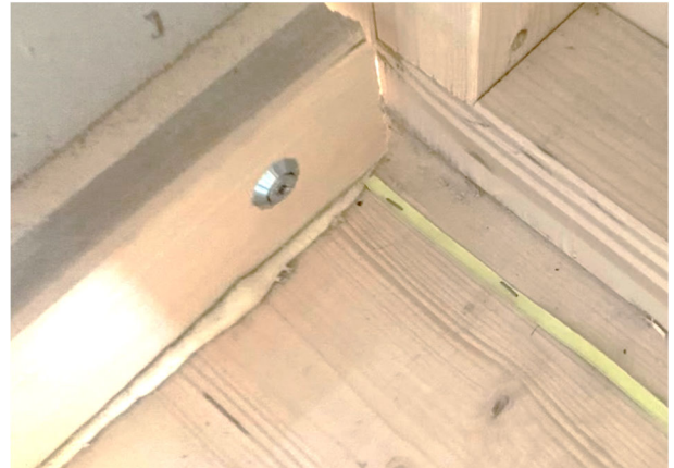
Abbildung 35: Parallele Befestigung des Sensorbandes mit Heftklammer, kein Kontakt zu den äusseren Sensorleitern
