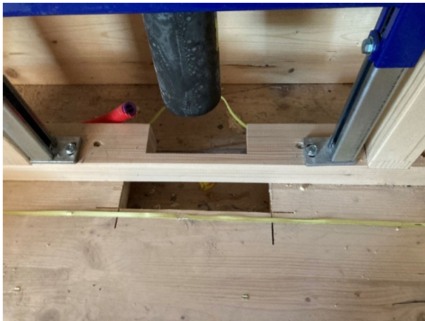
Abbildung 32: Verlegung der Sensorbänder im Steigschacht
