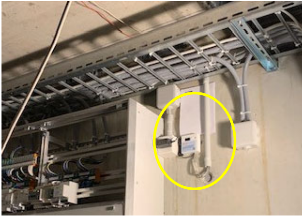
Abbildung 39: Position der PROGEO-Auswertereinheit smartex® microBOX im Technikraum
