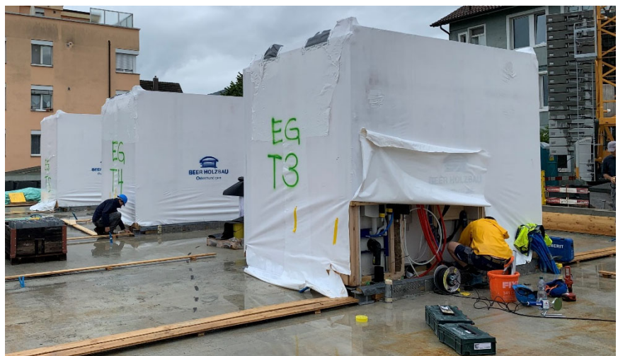
Abbildung 13: Anschluss der Haustechnik nach der Montage (Maison Climat)
