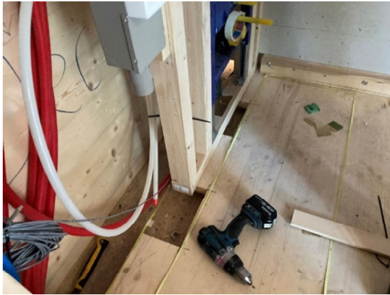
Abbildung 34: Diverse Installationen und graues Anschlusskabel des Sensorbandes
