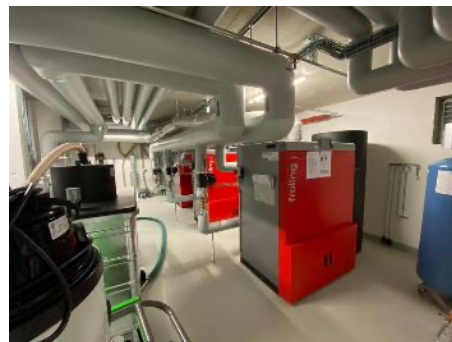
Bild 8 WUEB Roggwil mit drei Pelletkesseln mit zweimal 80 kW und einmal 100 kW Leistung.
