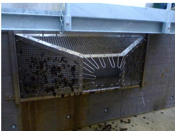
Bassin de comptage avec grille anti-retour qui empêche le retour des poissons dans la passe. Déplacement possible en cas d'arrivée massive de flottants (AquaPlus)
