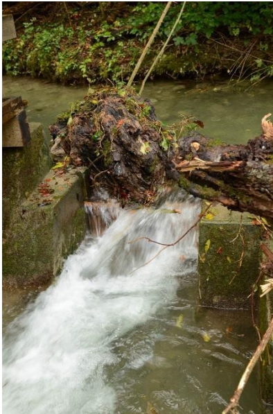
Fig. 4: L'obturation, même partielle, des passes à poissons par des corps flottants modifie leurs caractéristiques hydrauliques. Si ces flottants ne sont pas retirés régulièrement, ils peuvent entraver le passage des poissons vers l'amont et endommager certains éléments sensibles du dispositif (brosses de fond, éléments en bois, etc.) voire même blesser les poissons (Aquarius)
