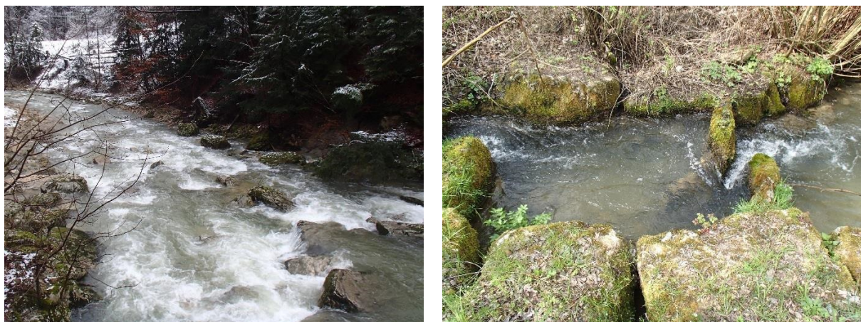
Fig. 9: Les crues peuvent déplacer les blocs d'une rampe en enrochement, ce qui peut modifier sa franchissabilité. Les blocs rocheux des passes « naturelles » peuvent, eux aussi, bouger avec le temps. (Aquarius)
