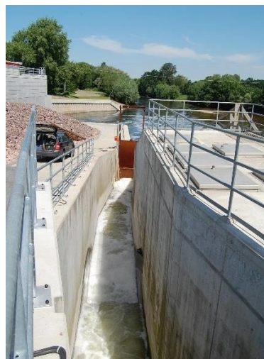
Dévalaison: exemple de chambre de comptage dans un exutoire (Ebel 2016)
