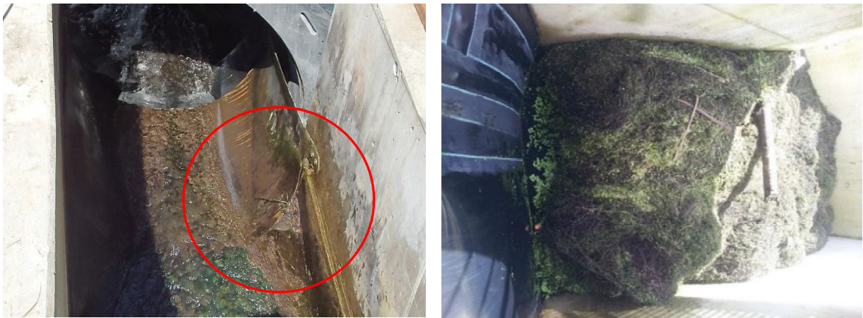
Fig. 7: Les éléments métalliques saillants peuvent blesser les poissons dans les passages rapides vers l'aval. Le même danger peut émaner de flottants accumulés dans l'exutoire ou à sa sortie (Aquarius/Økland et al. 2016)
