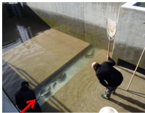
Des goulottes spéciales aménagées dans le bassin facilitent la capture des poissons (Aquarius)
