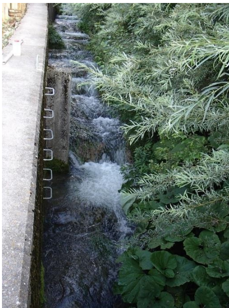
Fig. 3: Le contrôle de passes à poissons longées par des murs verticaux élevés demande un travail important et présente certains risques (Aquarius)
