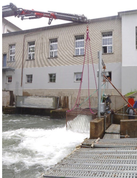
Un dispositif particulier de récupération et d'ancrage doit être utilisé si des flottants sont entraînés dans l'exutoire (Aquarius)
