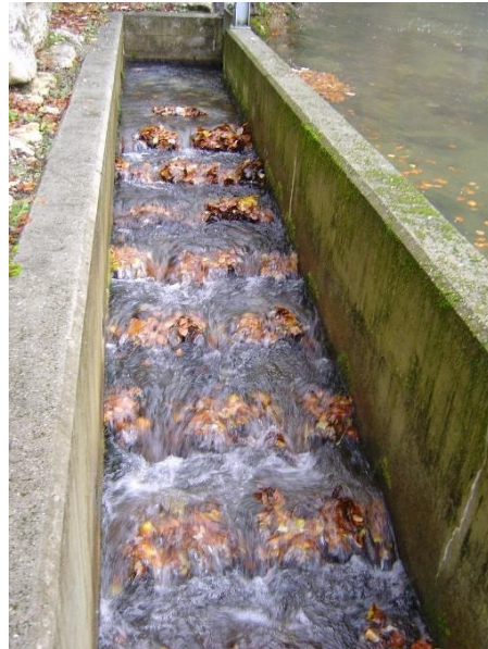
Fig. 4: L'obturation, même partielle, des passes à poissons par des corps flottants modifie leurs caractéristiques hydrauliques. Si ces flottants ne sont pas retirés régulièrement, ils peuvent entraver le passage des poissons vers l'amont et endommager certains éléments sensibles du dispositif (brosses de fond, éléments en bois, etc.) voire même blesser les poissons (Aquarius)
