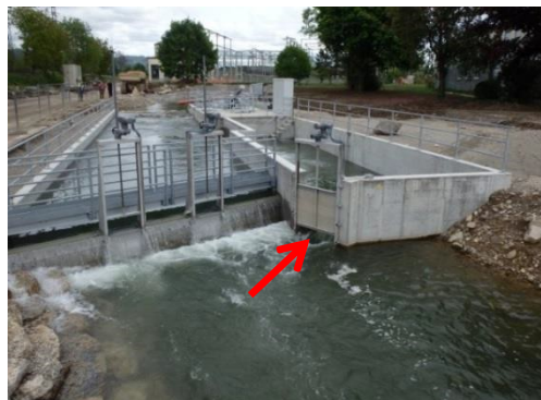
Les poissons remontant le courant pénètrent dans le bassin de comptage aménagé à côté de la passe (Aquarius)
