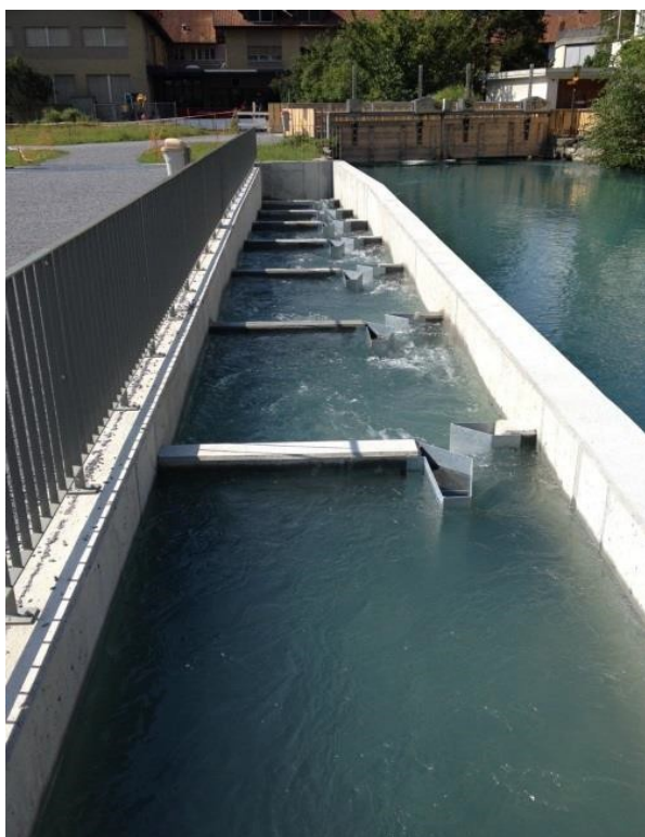
Passe de la petite écluse (Mühleschleuse), Aar
