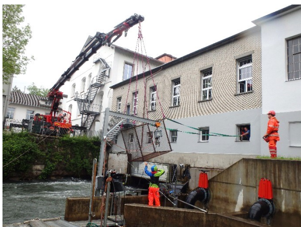
Un dispositif particulier de récupération et d'ancrage doit être utilisé si des flottants sont entraînés dans l'exutoire (Aquarius)
