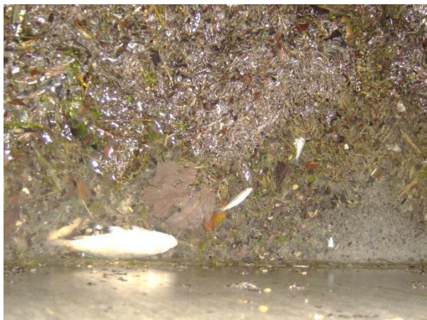
Une fois récupérés dans le bac, les éléments retenus par les grilles peuvent être facilement examinés (Aquarius)
