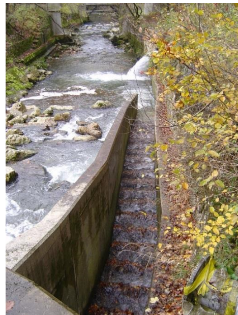
Fig. 3: Le contrôle de passes à poissons longées par des murs verticaux élevés demande un travail important et présente certains risques (Aquarius)
