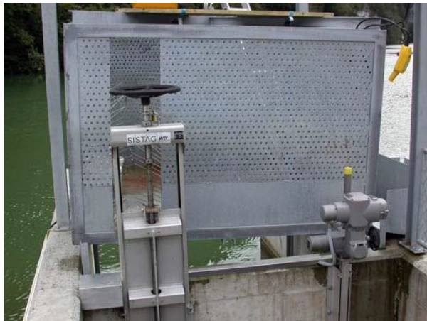
Levage réussi de la cage (Fischwerk)
