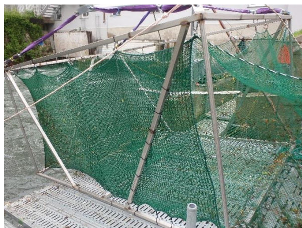
Renforcement d'une grande surface de filet suite à des signes d'usure (Aquarius)
