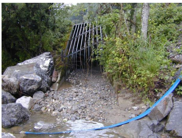
Fig. 6: L'accumulation de graviers à l'entrée du dispositif de franchissement peut empêcher ou limiter son accessibilité. Des sédiments fins peuvent se déposer dans les passes naturelles et les bassins de repos ; il est nécessaire de les retirer s'ils gênent le passage des poissons (Fischwerk/Aquarius)
