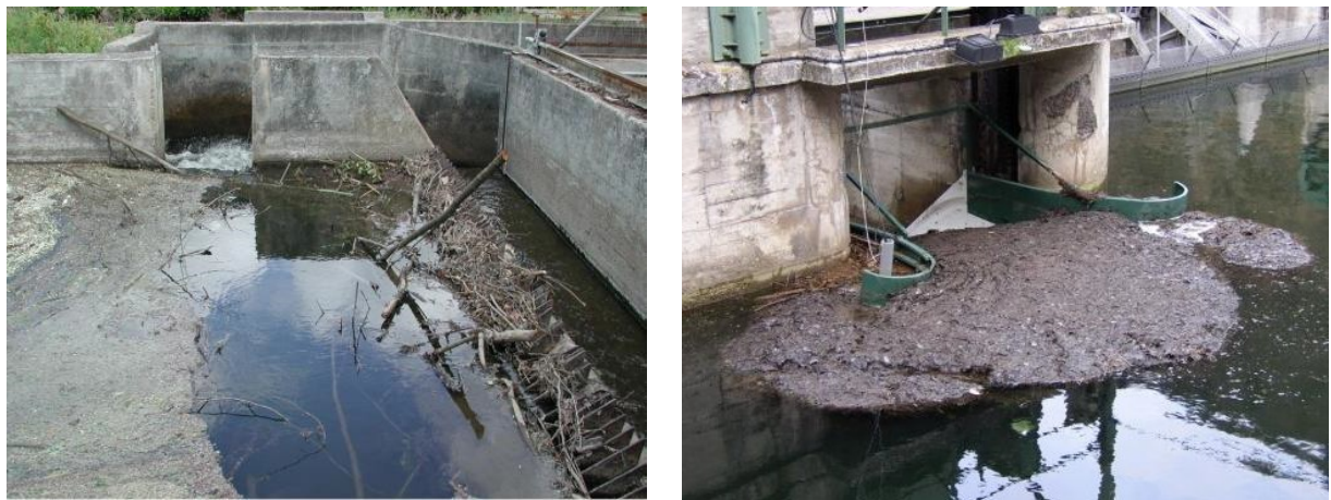
Fig. 8: L'accumulation de corps flottants au niveau de la grille ou de l'entrée dans l'exutoire peut entraver voire empêcher la dévalaison (Hilaire et al. 2014)
