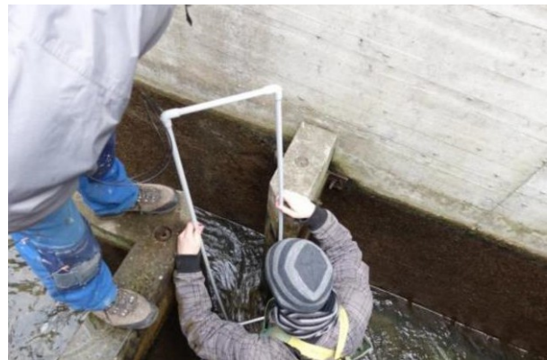
Installation d'une antenne dans une passe à fentes verticales (Peter & al. 2016)
