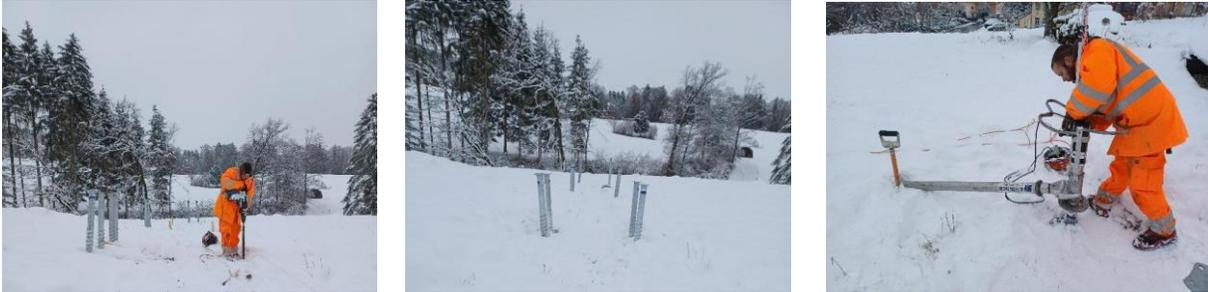
Figure 19. Pose des vis de fondation sur terrain brut.
