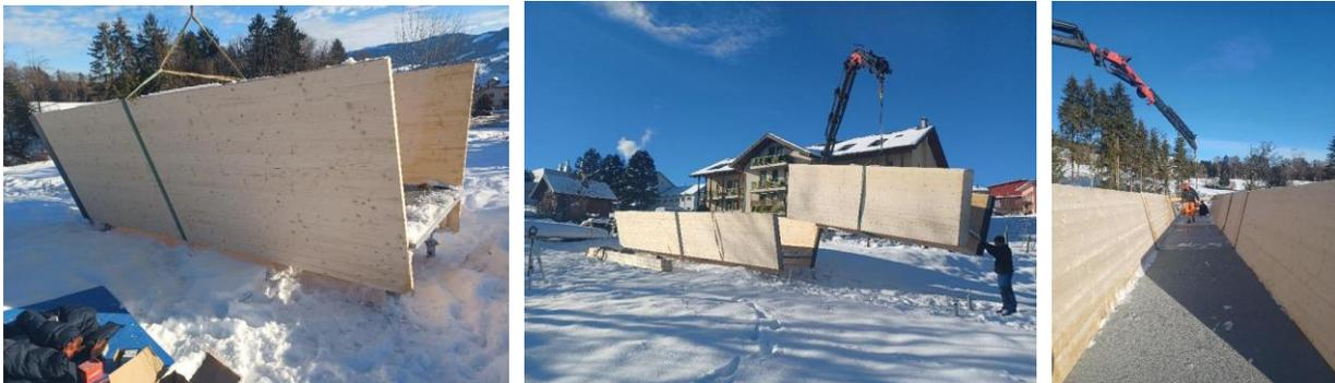
Figure 20. Pose des modules sur les vis de fondation.
