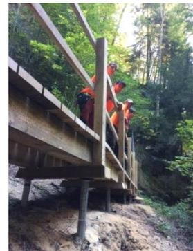
N'étant pas certains du degré de précision de ce type de fondations, nous avons rajouté la possibilité d'intercaler entre la fondation et la zone d'appui de la structure un support de réglage. Afin de rationaliser les coûts, un modèle courant a été utilisé et a permis de constater une très grande facilité d'adaptation sur la tête de la vis de fondation. Ceci permet d'éliminer le modèle proposé initialement, au coût significatif.
