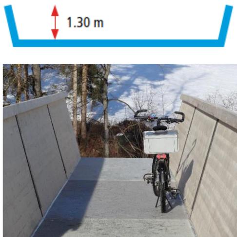
En ce qui concerne le garde-corps, si la hauteur de chute est supérieure à 1m sur le tronçon, alors celui-ci doit être au minimum de 1.30m. Grâce à la géométrie en V des garde-corps du module Urbanwood, on constate qu'un vélo a toute la latitude pour circuler. En effet, même avec une bande de roulement de seulement 1.60m, l'écartement du haut des garde-corps donne toute la largeur nécessaire au guidon du vélo quand celui-ci se rapproche du bord de la bande de roulement.
