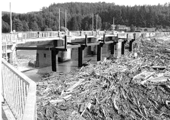
Figure 15. Râtelier grossier qui empêche les bois flottants d'obstruer le déversoir, sur la rivière Kamp (Boes et al. 2017).
