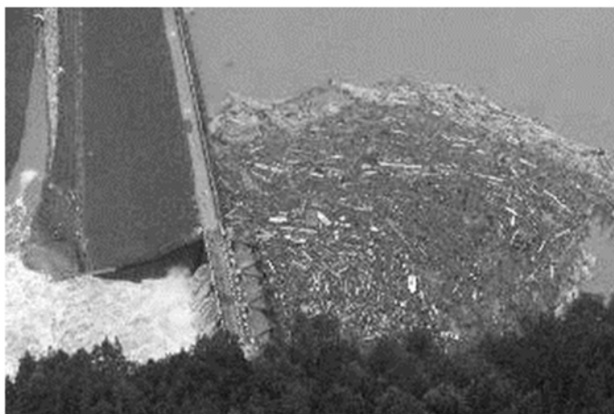
Figure 4. Obstruction d'un râtelier d'un évacuateur de crue en Autriche (Ministère Fédéral de l'Agriculture et des Forêts, de l'Environnement et de la Gestion des Eaux, Autriche).
