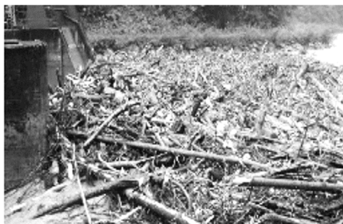
Figure 16. Obstruction du barrage de Gstins lors de la crue de 2005 (Vorarlberger Illwerke AG).
