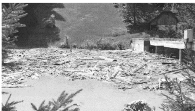
Figure 14. Accumulation de bois flottants dans le réservoir de Käppelistutz (EW Nidwalden).
