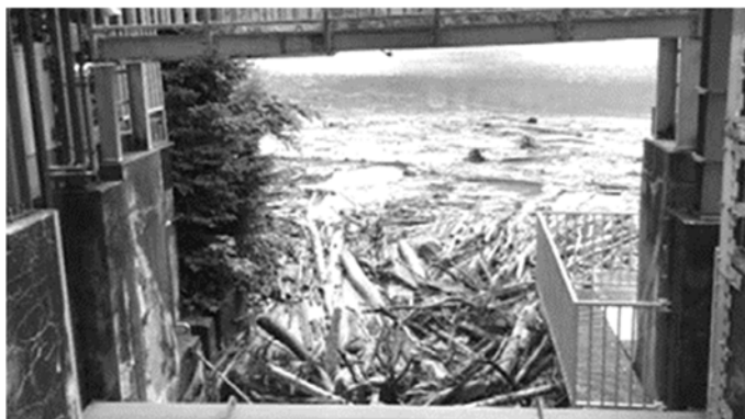
Figure 13. Blocage des bois flottants à Montsalvens (Boes et al. 2017).
