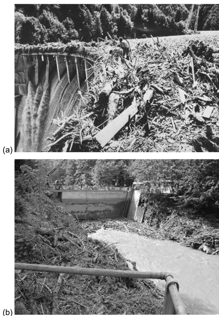
Figure 1. Obstruction de l'évacuateur de crue du barrage de (a) Palagnedra (Ofima), et (b) Schlattli (ebs Energie AG).
