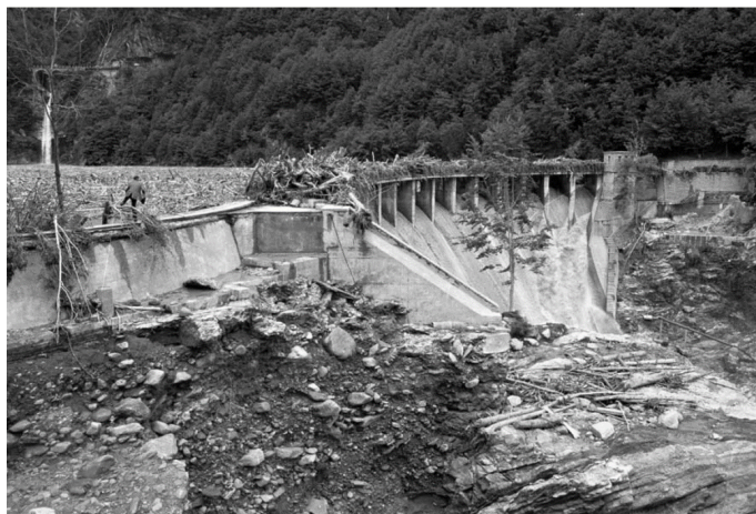
Figure 1. Obstruction de l'évacuateur de crue par des bois flottants sur le barrage de Palagnedra (STK 2017).
