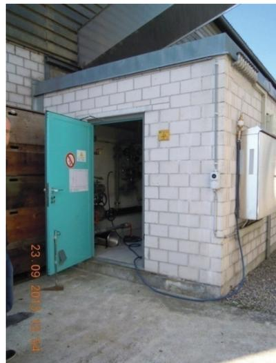
Abbildung 10: Die Einspeisestation der Energie 360° AG (Schlauch für Gasanalyse während der Inbetriebnahme).
