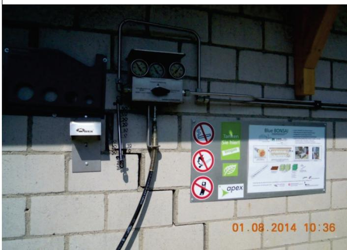
Abbildung 6: Manuelle 2-Bank-Konsole für die Fahrzeugbetankung
