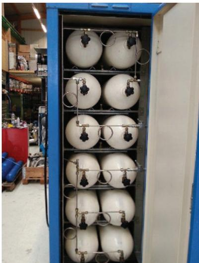
Abbildung 8: Der Hochdruckspeicher besteht aus 12 x 75 Liter Einzelflaschen
