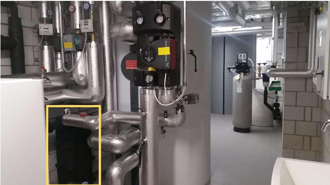
Abbildung 12: Vordergrund: Wärmepumpe mit Heizkreis und Wärmetauscher für «Natural Cooling» über Sonde (eingerahmt), Mitte: Pufferpeicher für Heizung, Hintergrund: Speicher für Brauchwarmwasser (Quelle: Smart Energy Control)
