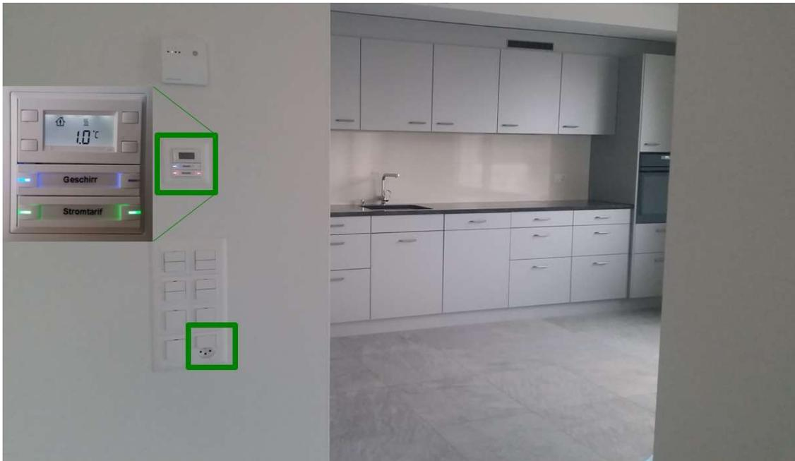
Abbildung 7: Ausrüstung der Wohnungen mit KNX: Temperaturüberwachung, Solarbetrieb für Geschirrspüler, Anzeige Stromtarif, Solarsteckdose (Quelle: Smart Energy Engineering)
