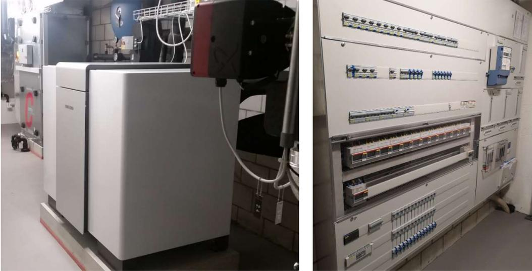
Abbildung 11: Links: Stiebel-Eltron Wärmepumpe für ein Gebäude und kontrollierte Lüftung (Hintergrund), Rechts: Installation der privaten Stromzähler für die einzelnen Wohnungen, Disporäume und Verbraucher (Quelle: Smart Energy Control)
