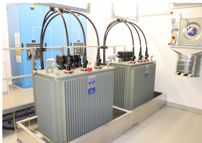
Le RCP Erlenmatt Est est raccordé au réseau moyenne tension du fournisseur d'électricité bâlois IWB par deux transformateurs de 630 kVA (sur la photo). Photo: B. Vogel
