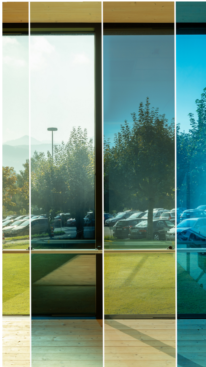
Das Fenster des Lichtmesscontainers auf dem Campus der Hochschule Luzern in Horw zeigt vier Einstellungen von elektrochromen Gläsern (v.l.n.r.): ungetönt; stufenloser Verlauf von oben hell bis unten getönt; stufenloser Verlauf von oben getönt bis unten ungetönt; getönt. Fotomontage: Licht@hslu
