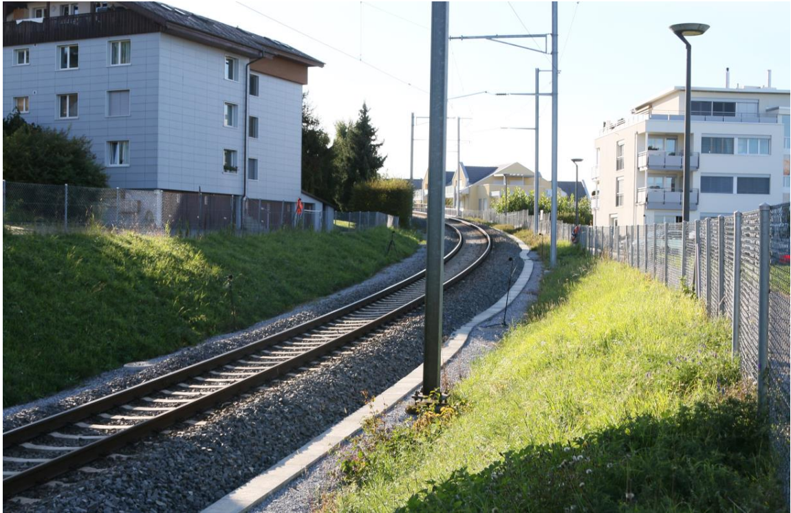
Versuchsstrecke Bogen Riedmatt Blick Richtung Bhf. Riedmatt
