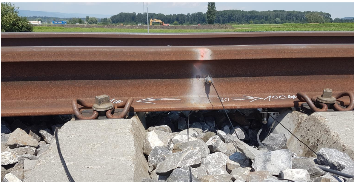
Versuchsabschnitt km 24.9 Nachmessung Juni 2020 mit Sensor für Schieneneinsenkung
