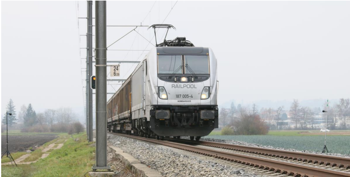
Kontrollabschnitt km 24.66 mit weicher Zwischenlage und Güterzug
