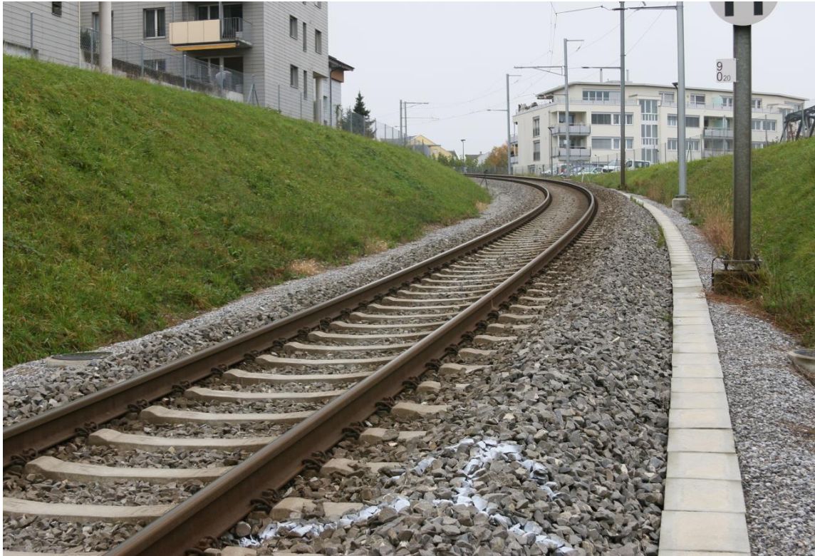
Versuchsstrecke Bogen Riedmatt ab Pfeil mit BATEGU Zw umgerüstet
