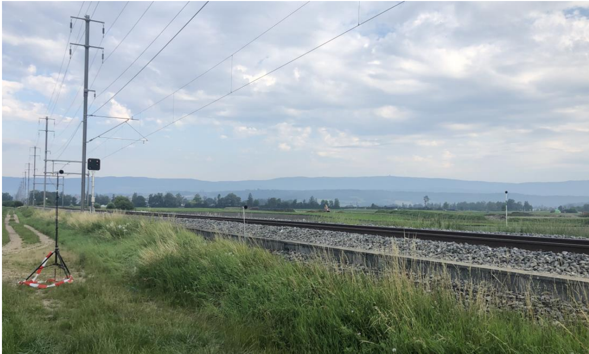
Kontrollabschnitt km 24.66 mit weicher Zwischenlage
