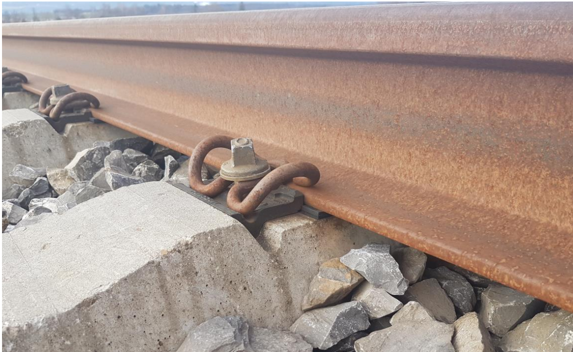
Testabschnitt mit BATEGU Zwischenlagen bei Kerzers UIC60 Schiene
