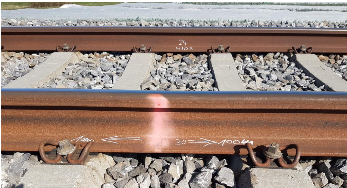
Testabschnitt mit BATEGU Zwischenlagen Richtung Kerzers
