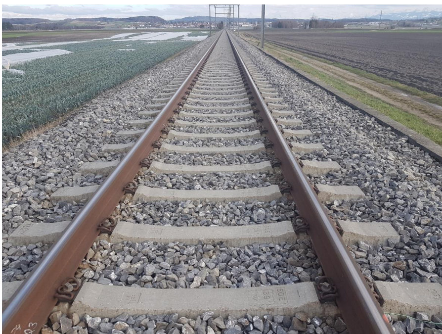
Abbildung 8-12: Testabschnitt mit BATEGU-Zwischenlagen Richtung Kerzers
