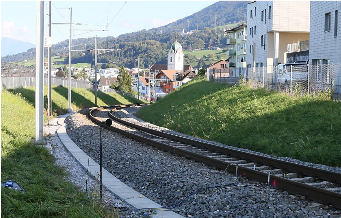
Lichtschranken am Versuchsabschnitt Bogen Riedmatt Blick nach Wollerau
