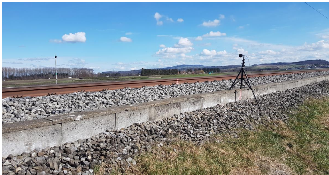
Abbildung 8-10: Testabschnitt mit BATEGU-Zwischenlage bei Kerzers
