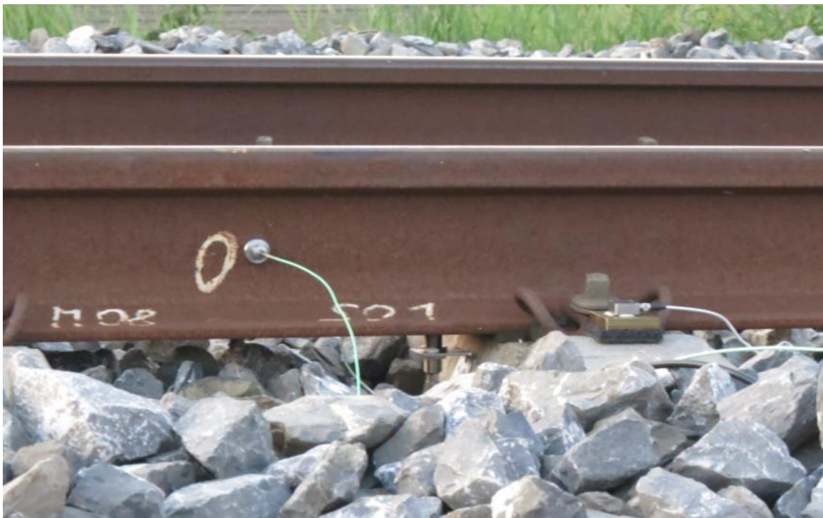
Kontrollabschnitt km 24.66 mit weicher Zwischenlage und Sensoren an Schiene und Schwelle
