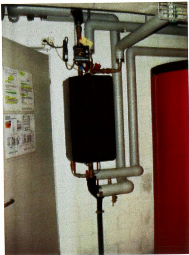
Bild 3 BWW-Bereitungsinheit „Akvmatik“, bestehend aus 3 Wärmetauschern
