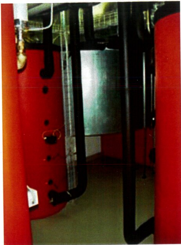
Bild 2 Speicheranlage, total 4 Speicher mit je 900 Liter Inhalt
