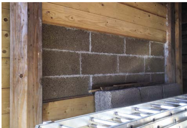
3 Der Anbau am «Doppio» ist mit Hanfkalksteinen gemauert. L'extension du «Doppio» est en briques de chanvre. L'edificio annesso al «Doppio» è realizzato con mattoni di canapa. FOTO: DANIELLE FISCHER
