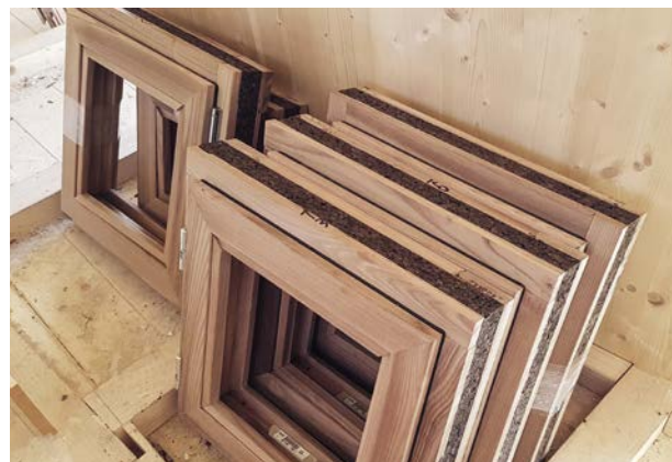
4 Die Fenster aus Kastanienholz wurden mit einer lokalen Firma entwickelt, die nun mit Holz aus ihren Wäldern Bauteile fertigen kann. Les fenêtres en châtaignier ont été réalisées avec une entreprise locale, qui façonne désormais des éléments de construction avec le bois de ses forêts. Le finestre in castagno sono state realizzate da un'azienda locale che utilizza il legno delle foreste autoctone per la produzione di componenti. FOTO: MONVISO INSTITUT
