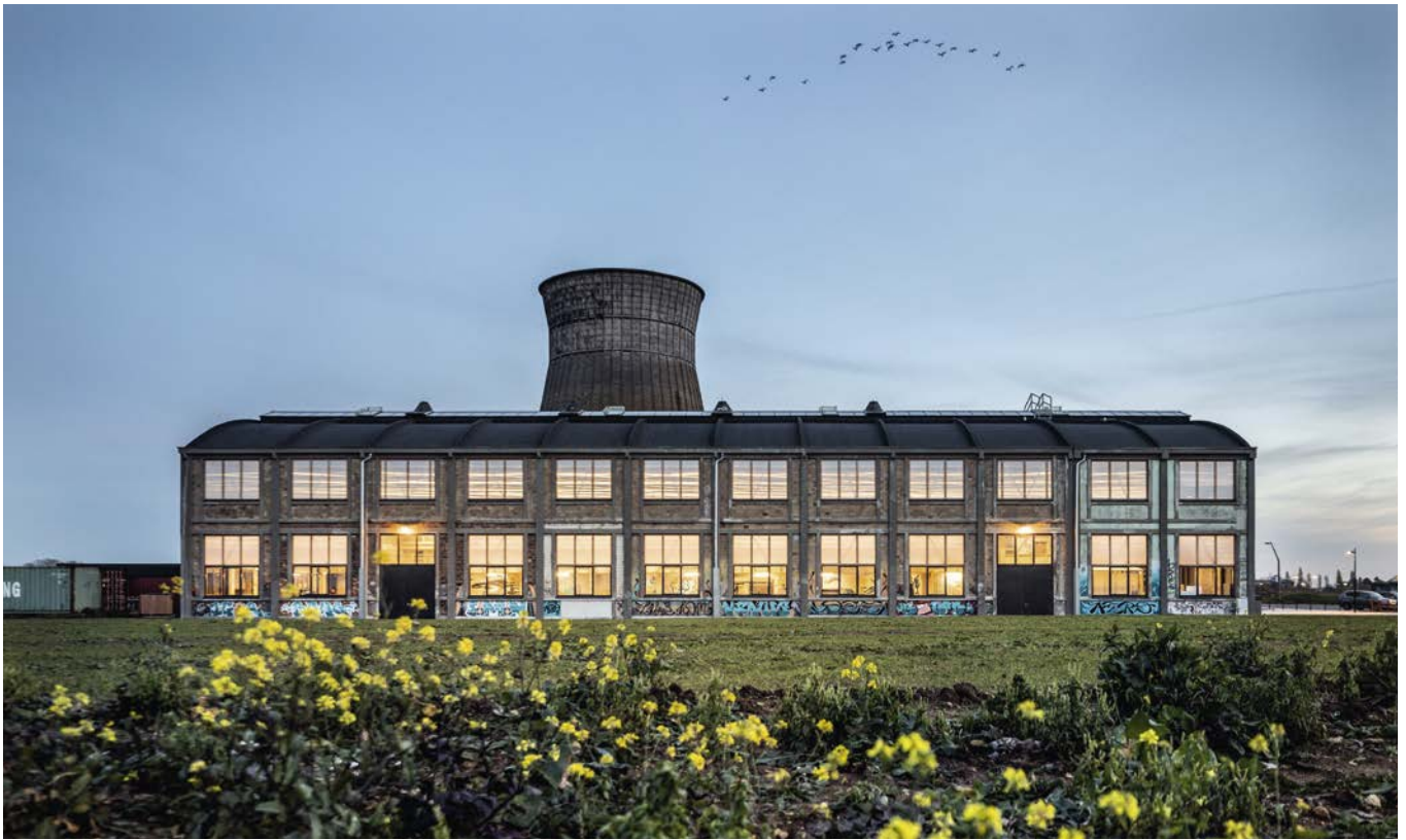
2 Am Fuss des letzten Schornsteins der Industrieanlage Colombelles erwacht die Grande Halle zu neuen Aktivitäten.
