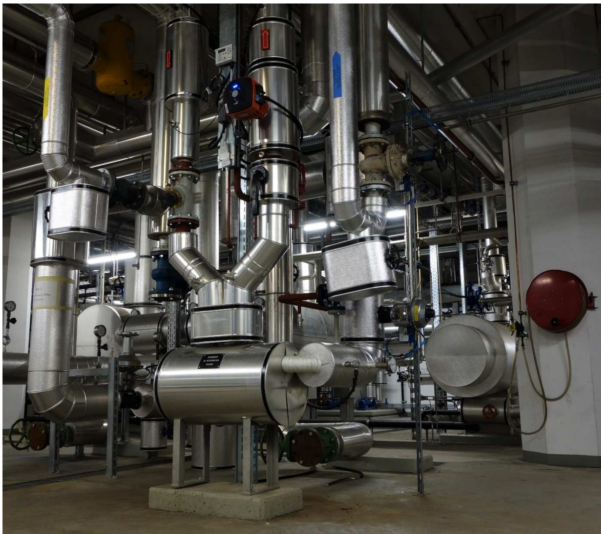
Figure 6 : Echangeur de chaleur entre l'installation solaire et le réseau de distribution de chauffage
