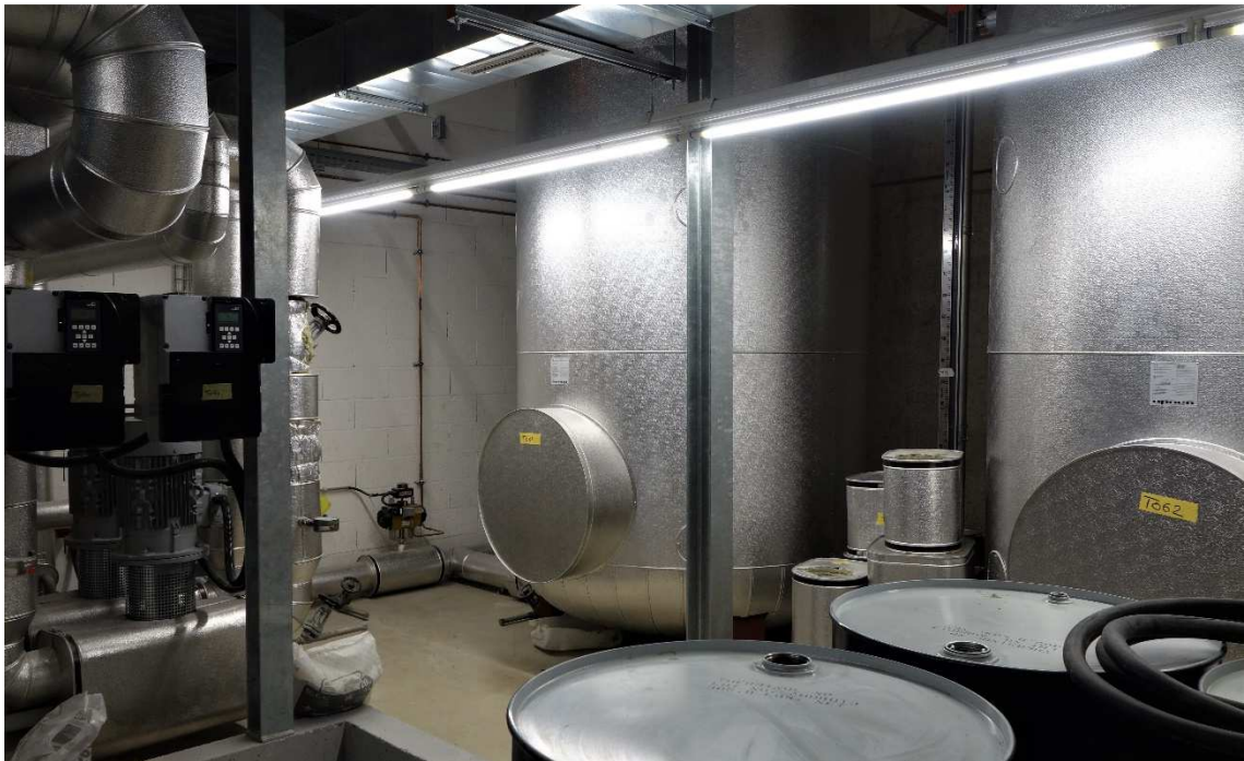
Figure 7 : Cuves de rétention du niveau T. Le volume est de 2 x 5'960 litres
