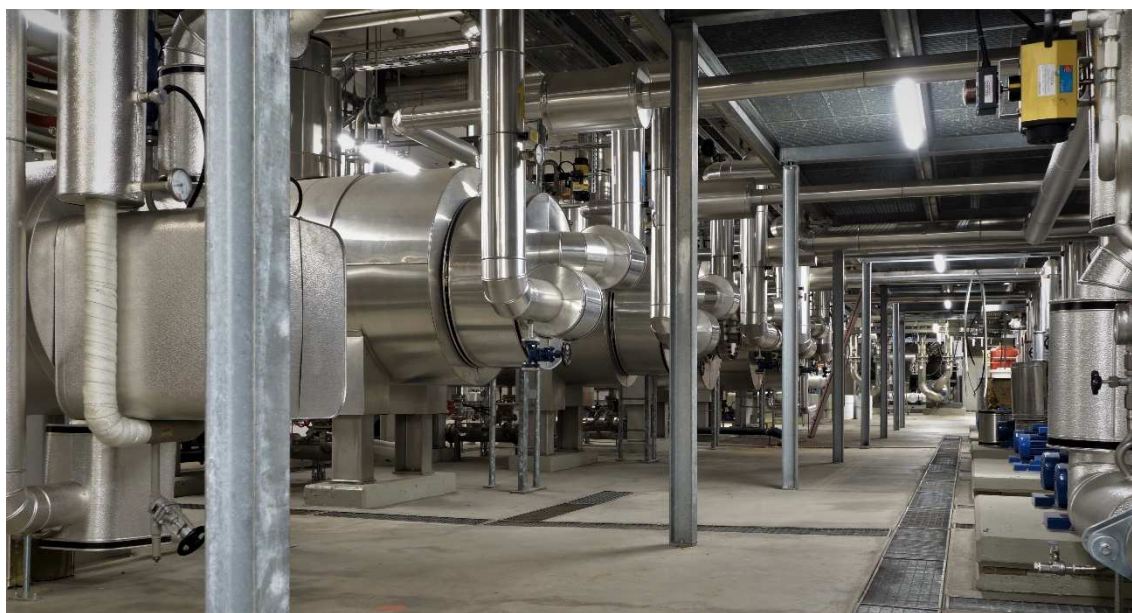
Figure 4 : Vue des générateurs de vapeur de la centrale OPERA
