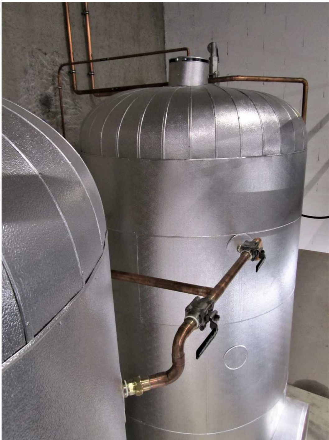
Figure 16 : Nouveau raccordement des cuves au niveau T suite à la modification.
