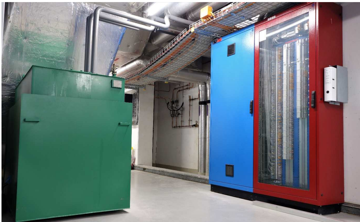
Figure 17 : Cuve de rétention en sortie de soupape.
