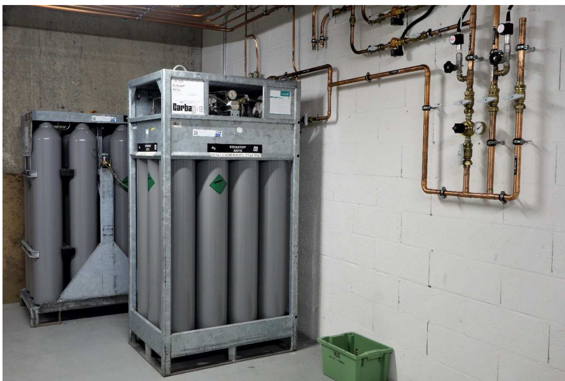
Figure 9 : rack d'alimentation en azote
