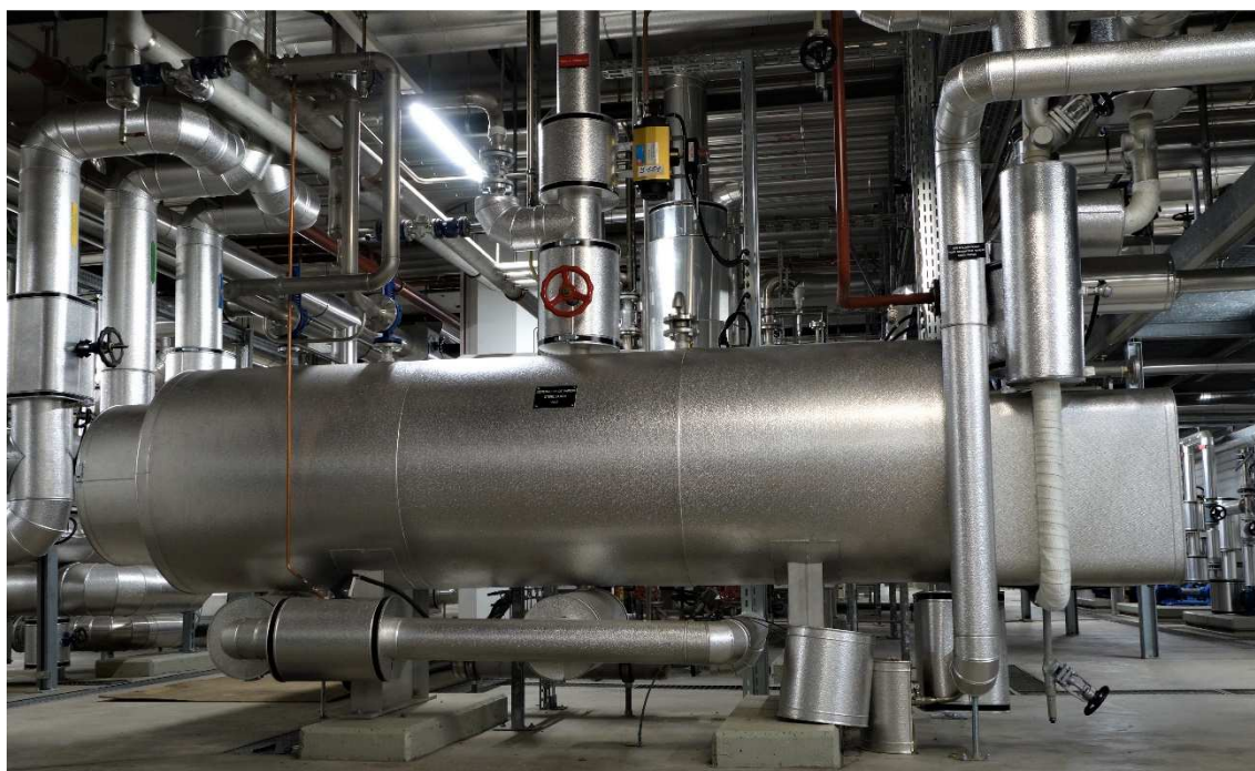
Figure 5 : Générateur de vapeur alimenté par l'énergie solaire à travers le réseau d'huile thermique.
