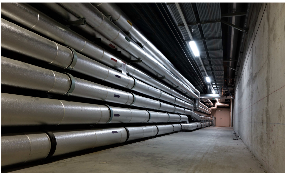
Figure 10 : Liaisons hydrauliques entre les bâtiments Opéra et Julliard
