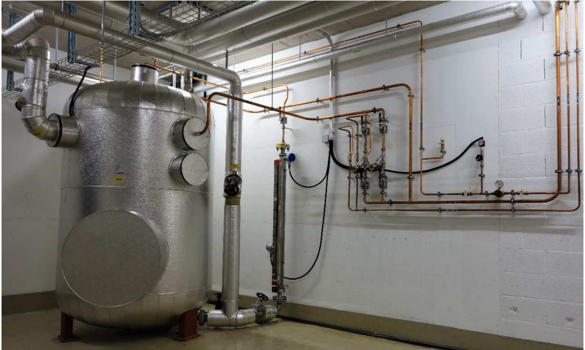
Figure 8 : Cuve de rétention du niveau 9
