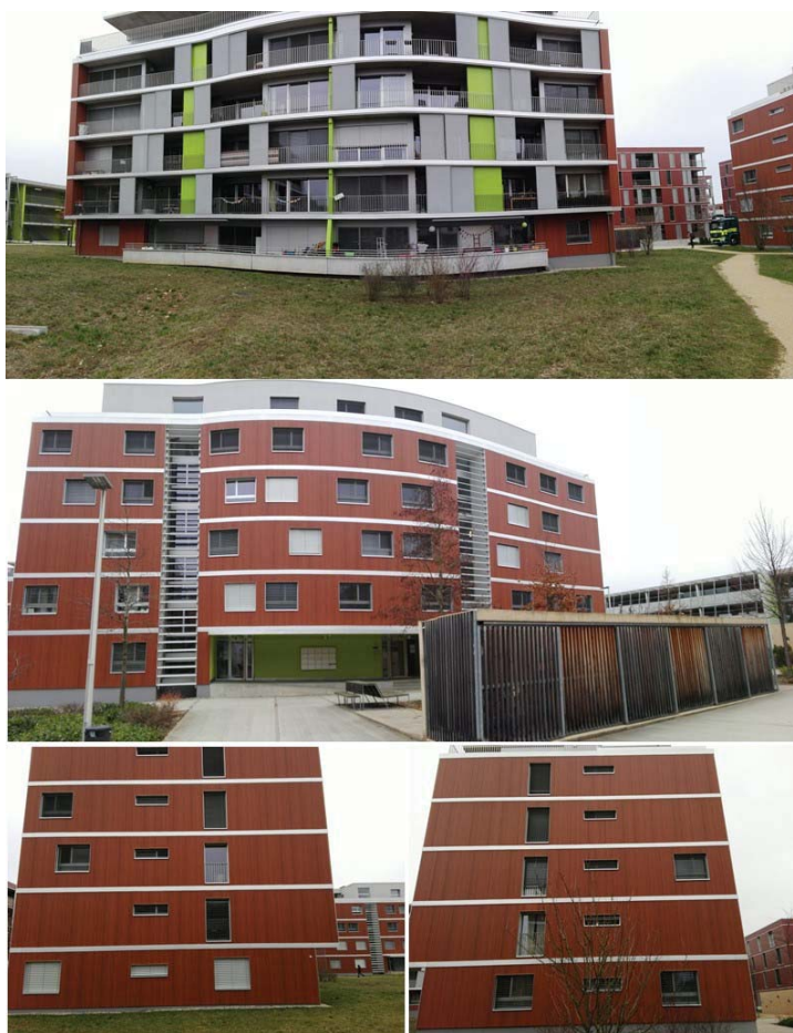
Figure 33 : Photographies des façades du bâtiment.
