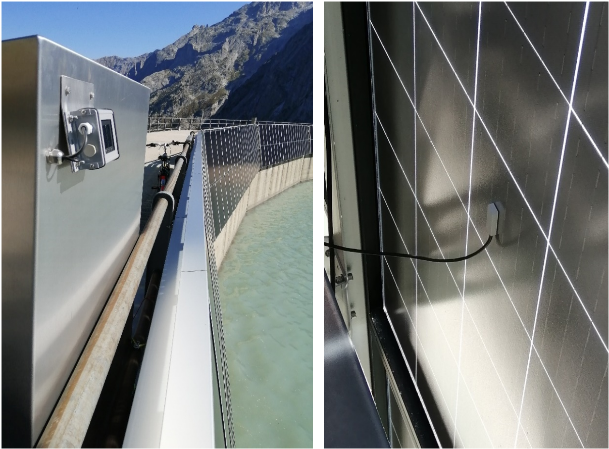
Abbildung 4 Einstrahlungssensor an GAK 1 (links); Modultemperaturfühler an Modulrückseite oberes Modul Nähe GAK 1 (rechts)
