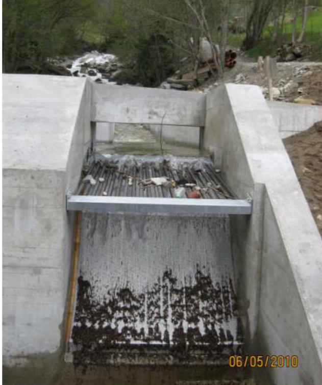
Abbildung 3: Coanda-Rechen mit obenliegendem Schutzrechen. Suonen-Fassung obere und untere Bitscheri, Gemeinde Naters, Kt. Wallis, Kapazität 200 l/s, Quelle: unbekannt
