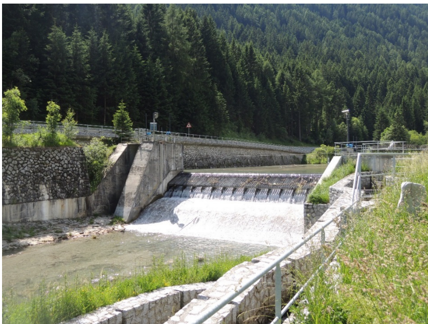
Abbildung 2: Fassung am Vallerbach bei Vals, Südtirol (Italien); Blick gegen die Fließrichtung
