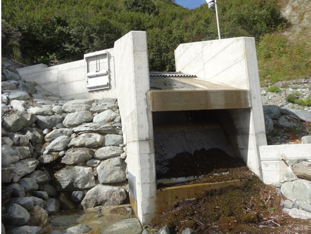
Abbildung 5: Fassung am Gorpatbach, Gde Eischoll (VS). Coanda-Rechen der Fa. Andaco GmbH. Der oben sichtbare Schutzrechen mit runden Stäben ist gegenüber dem Coanda-Rechen versetzt angeordnet. Das Grobgeschiebe wird über den Schutzrechen abgeführt
