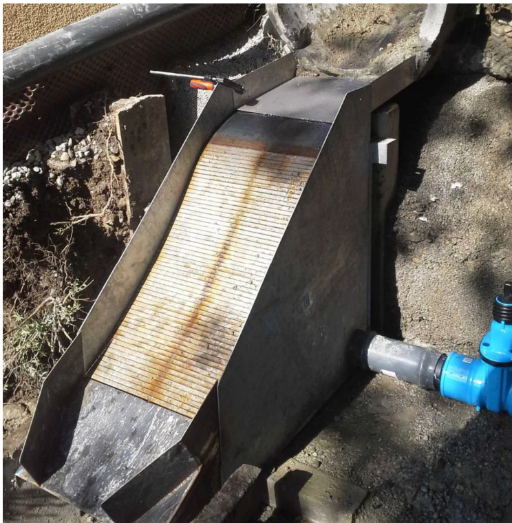
Abbildung 7: Coanda-Rechen (QWehr-Rechen Ravensburg) der Fa. Stocker Technik GmbH. Quelle: www.stockertechnik.at
