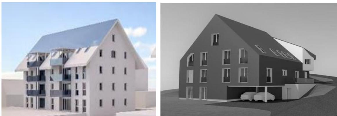
Abbildung 1: Links: MFH Huttwil mit solarthermischer Energieerzeugung auf dem Dach. Rechts: MFH Anbau Benzenschwil mit photovoltaischer Energieerzeugung auf der gesamten Gebäudehülle. Beide Gebäude nutzen einen saisonalen Wasserspeicher. Quellen: Jenni Liegenschaften AG & synergieplus.ch
