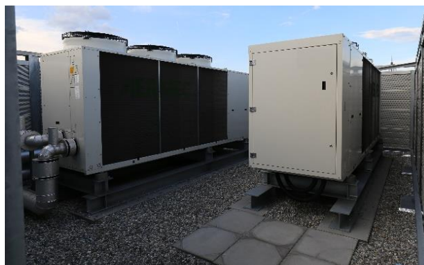
Figure 35 : Bâtiment chauffé dans le cadre du retour d'expérience « St-Julien » (à gauche) et pompes à chaleur air-eau en toiture pour le chauffage et l'ECS (à droite)
