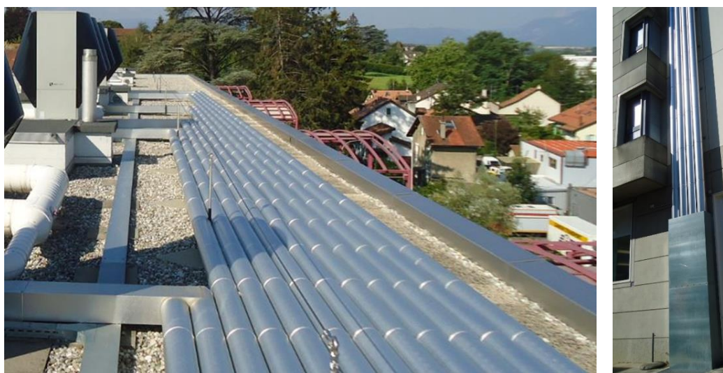
Figure 33 : Aperçu des conduites de liaison en toiture (gauche), et en façade entre la toiture et la chaufferie (droite).
