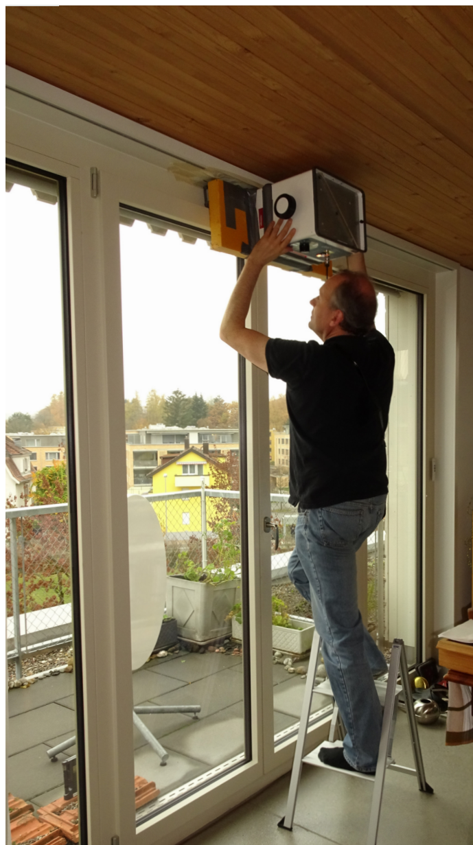
Dans le cadre d'un projet de recherche, les scientifiques de la Fachhochschule Nordwestschweiz (FHNW) et de la Hochschule Luzern (HSLU) ont réalisé des mesures dans huit appartements équipés de ventilateurs de fenêtres. Sur l'image: montage d'un dispositif pour la mesure de l'air entrant. Photo: FHNW/HSLU
