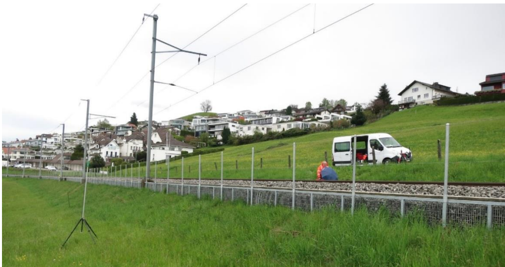
29.04.2021 Messtelle Geraden in Riedmatt km 9.9
