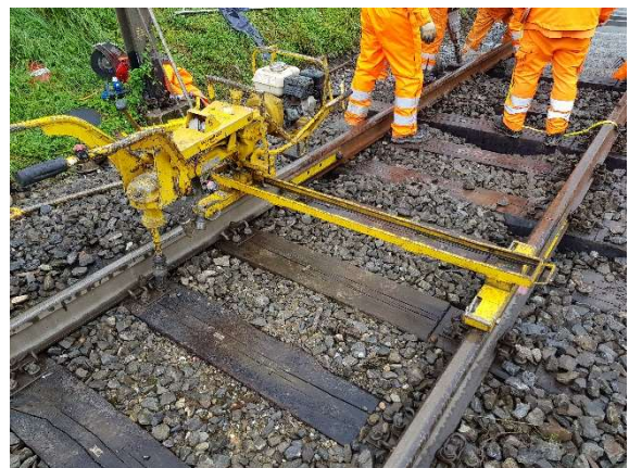
Bild 4: eingesetzte Tirefoneuse
