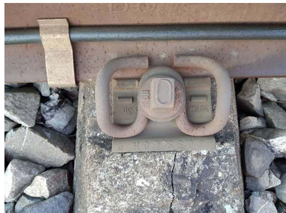
Bild 2: Skl 1 bei B70 Schwelle
