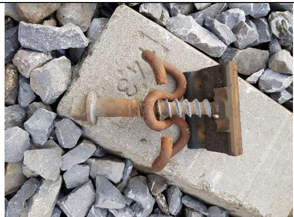
Bild 8: Schwellenschraube mit Skl und Wfp
