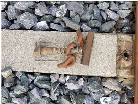
Bild 7: Schwellenschraube mit Skl und Wfp
