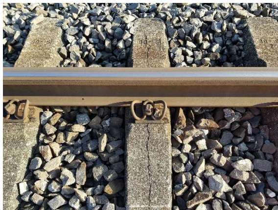
Bild 1: B70 Schwelle gerissen
