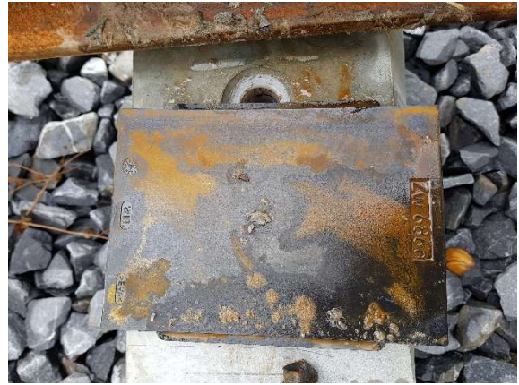
Bild 2: harte Zw 686a mit langen Lippen
