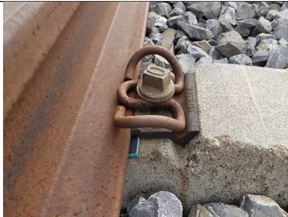
Bild 3: Zw Getzner eingebaut
