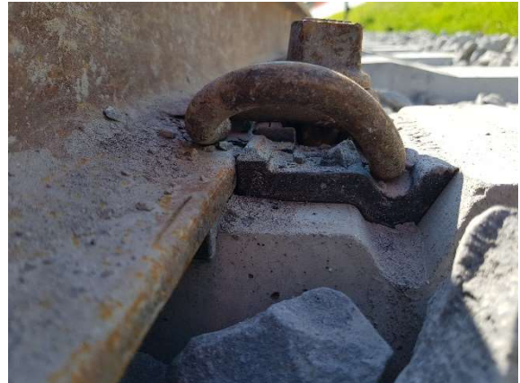
Bild 8: Steine zwischen Wfp und Skl
