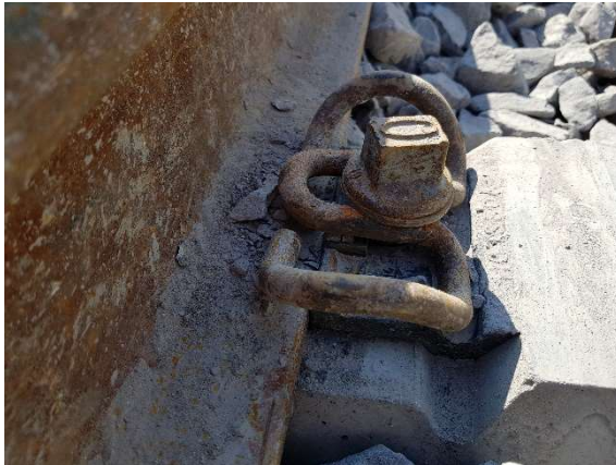
Bild 7: grosser Luftspalt Skl zu Wfp
