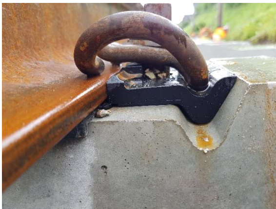
Bild 5: grosser Luftspalt Skl zu Wfp
