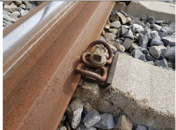
Bild 4: Vereinzelt Skl zu wenig vorgespannt
