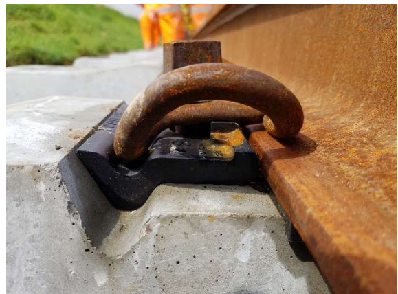
Bild 6: Skl korrekt montiert
