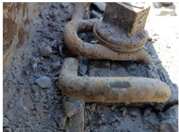
Bild 10: Verschmutzung nach Stopfen
