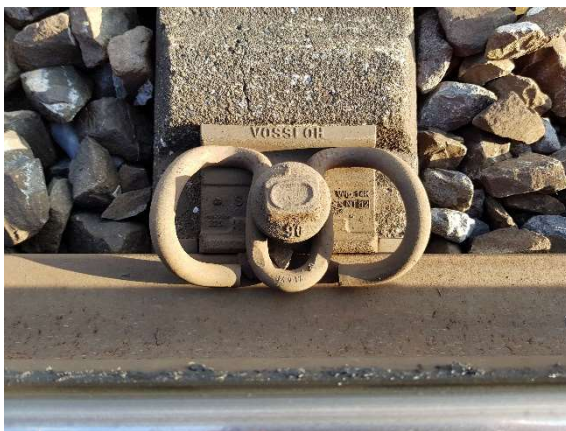
Bild 5: Wfp 14K mit Kippschutz NT 12
