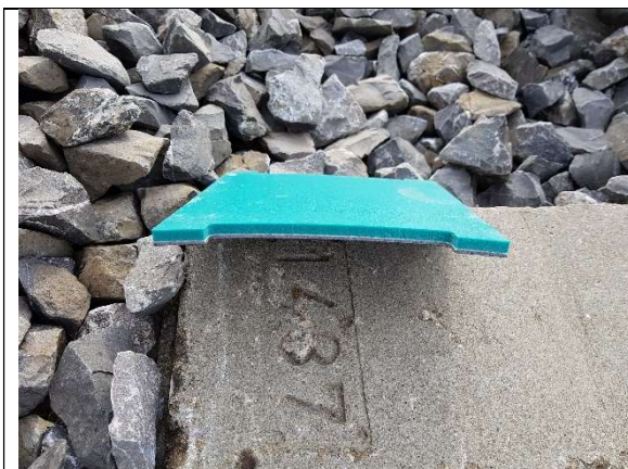
Bild 1: Eingebaute Zw Getzner
