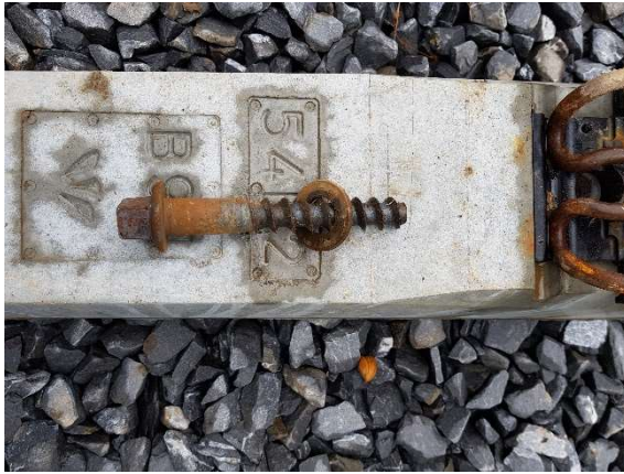
Bild 1: Schwellenschraube 0
