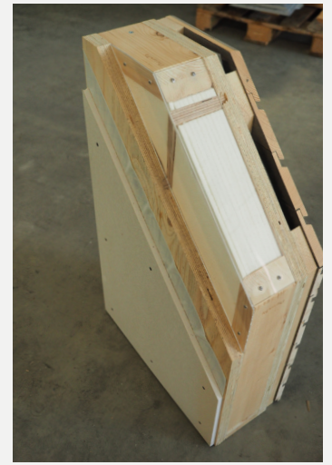
Un élément mural conventionnel avec isolation en laine de roche (à gauche) est nettement plus large que le nouvel élément avec isolation en aérogel. Photos: Martin Gruber
