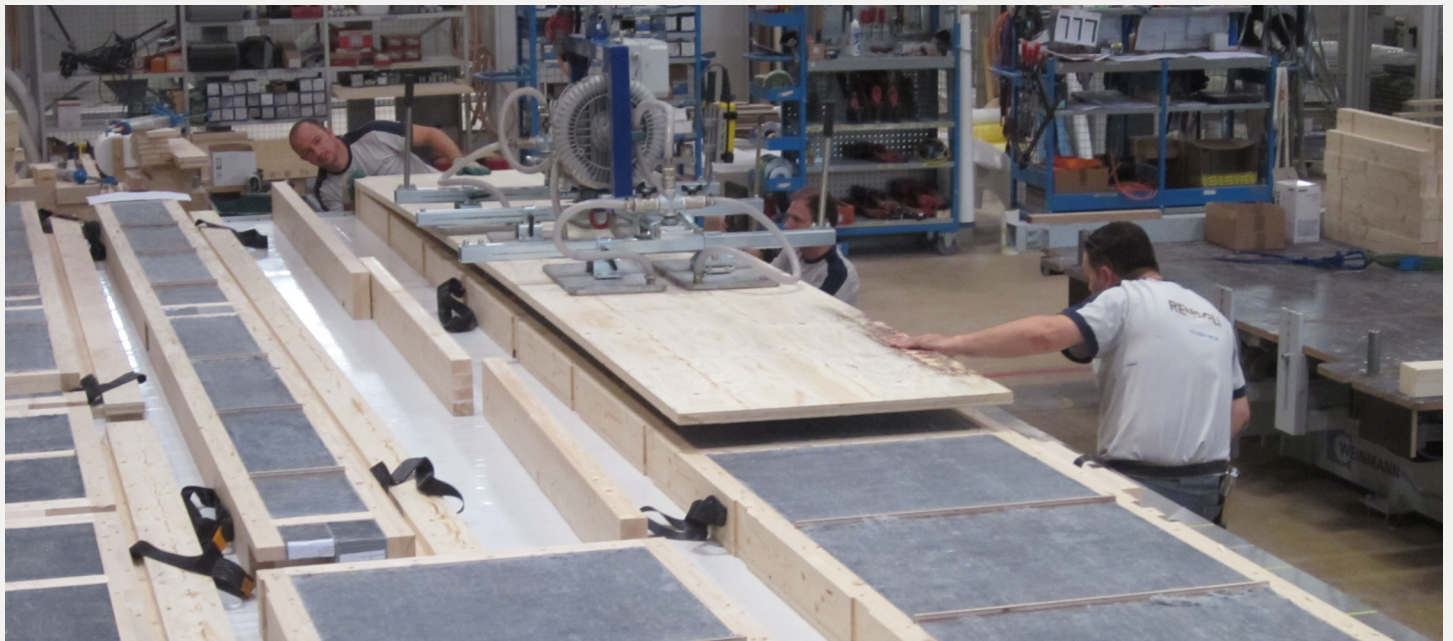
Production d'éléments muraux préfabriqués avec isolation par aérogel (en gris) à l'usine de Renggli à Schötz (LU). Photo: Martin Gruber
