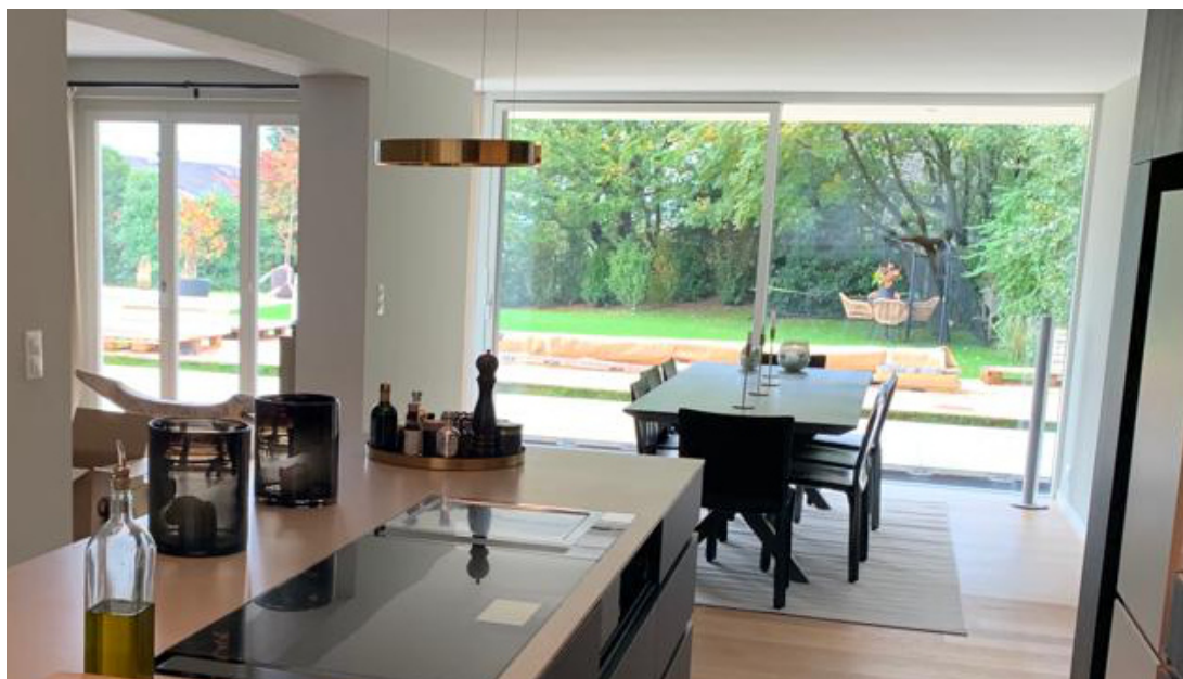
La fenêtre coulissante («Skyline») récemment développée par la Gerber-Vogt AG semble plus filigrane que la fenêtre classique (à l'arrière à gauche) en raison de sa section centrale d'une largeur de seulement 60 mm. Photo: Gerber-Vogt AG
