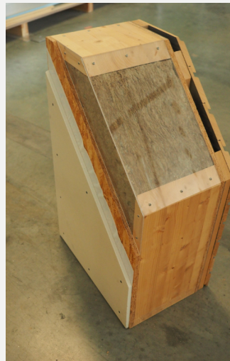
Ein Wandelement mit Steinwollen-Dämmung (links) ist deutlich breiter als das Element mit Aerogel-Dämmung. Fotos: Martin Gruber
