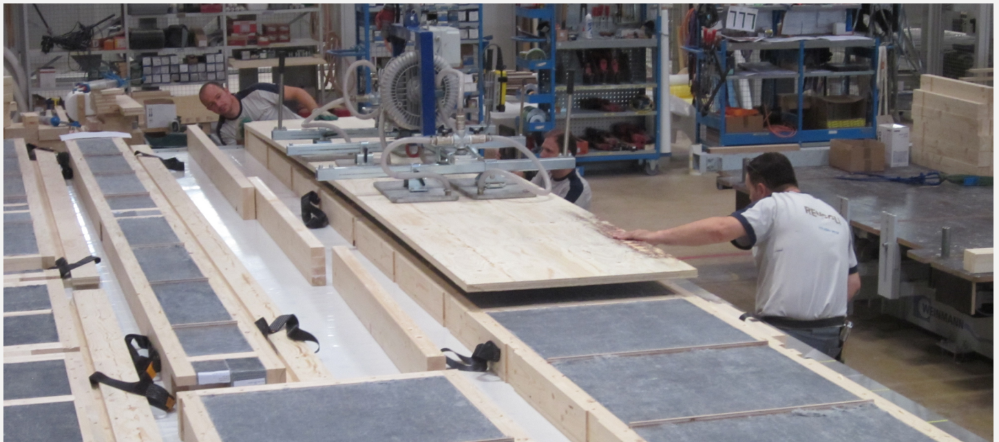
Produktion der vorgefertigten Wandelemente mit Aerogel-Dämmstoff (grau) im Renggli-Werk in Schötz (LU). Foto: Martin Gruber
