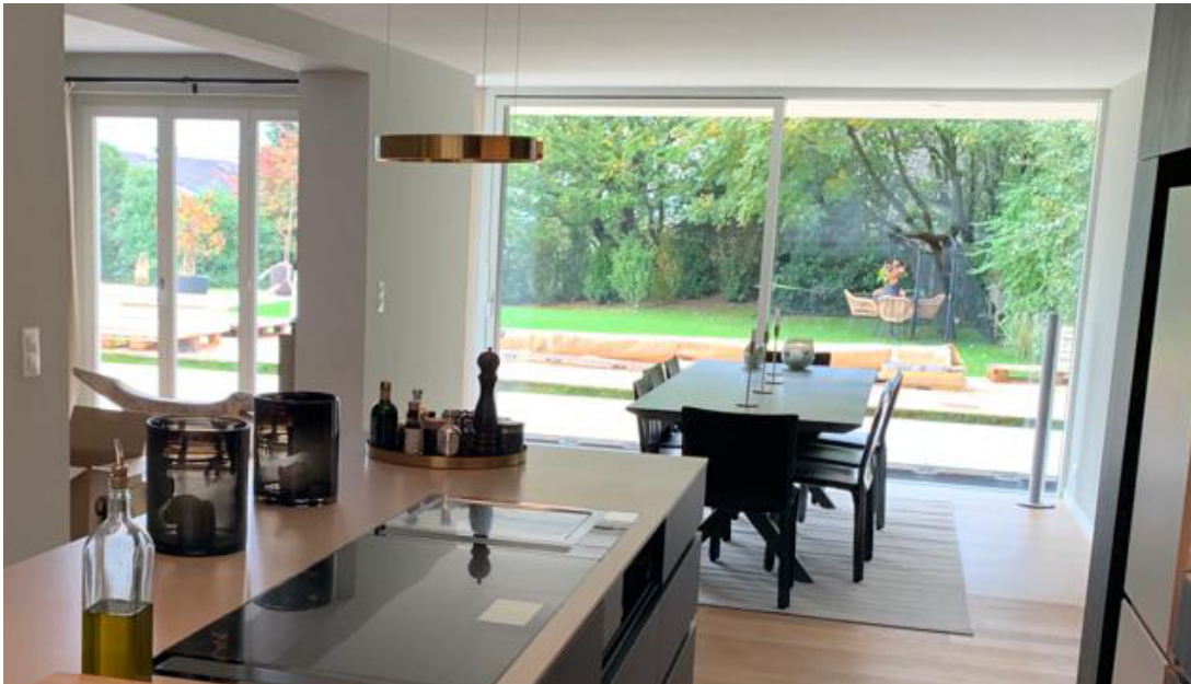
Das von der Gerber-Vogt AG neu entwickelte Schiebefenster («Skyline») wirkt wegen seiner bloss 60 mm breiten Mittelpartie filigraner als das konventionelle Fenster (links hinten). Foto: Gerber-Vogt AG
