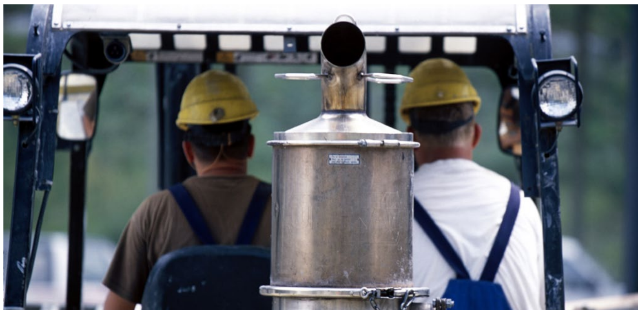
Filtre à particule installé sur un engin de chantier sur le site de la NFLA à Amsteg (UR)
