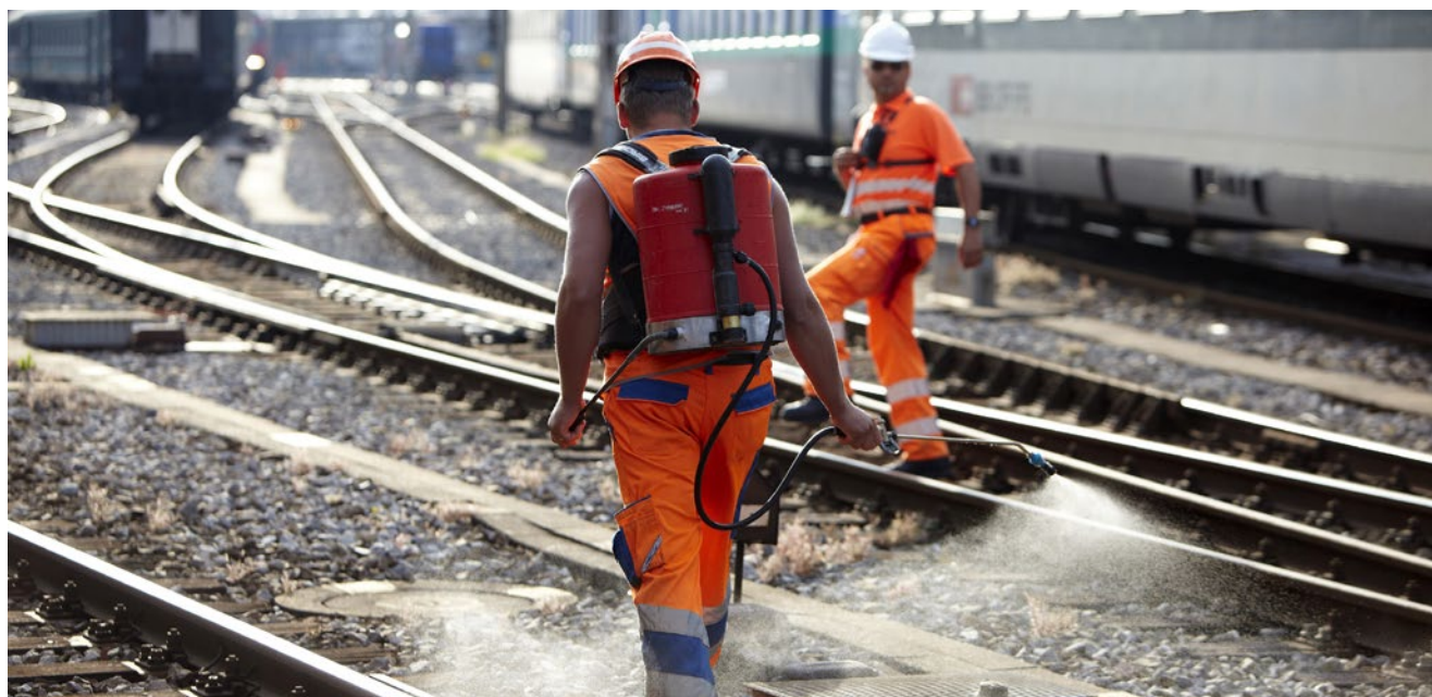
Désherbage des voies ferrées par les CFF
