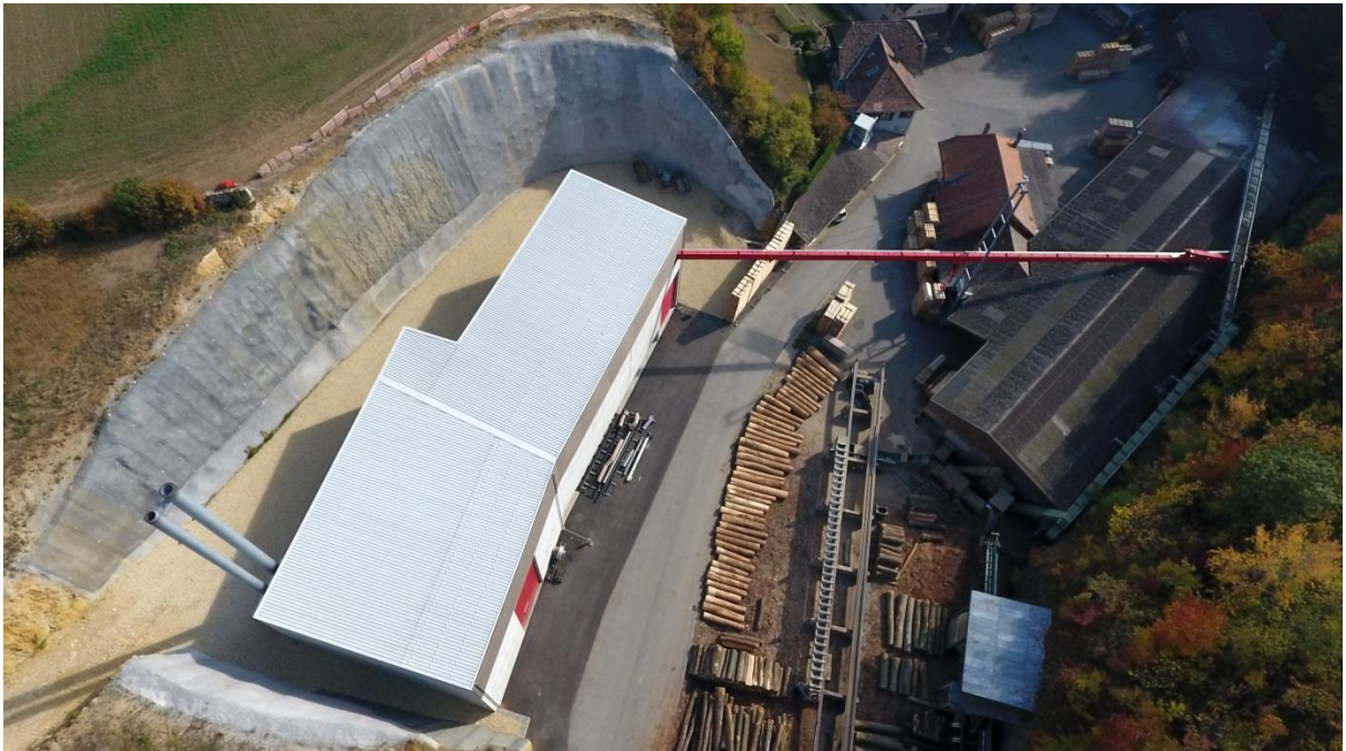
Abbildung 1: Neue Heizzentrale mit Sägewerk Burgat SA
