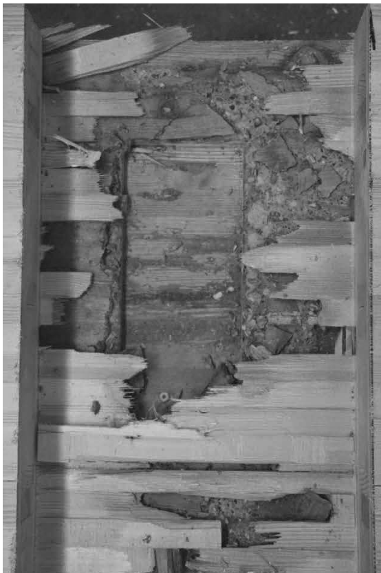
Abb. 4.35: Durchfeuchtete Nocken, Beispiel 1.
