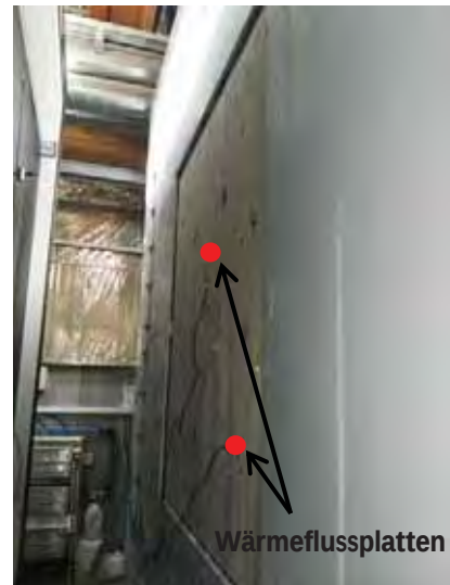
Abbildung 17: Wärmestromplatten auf dem Testelement.
