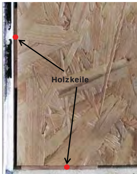
Abbildung 9: Ansicht der Holzkeile.
