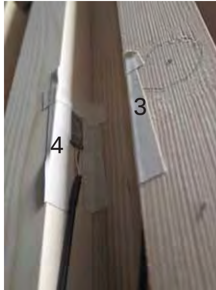
Abbildung 20: Wärmestromplatte auf dem Testelement an der Seite des herausstehenden Brettes (Position 3 und 4).
