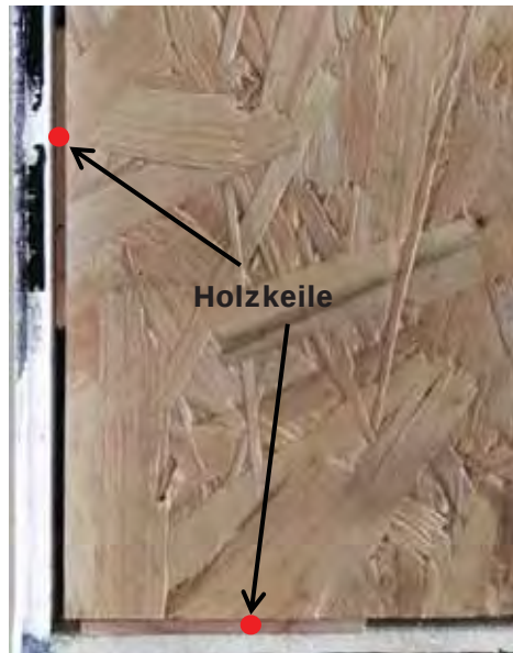
Abbildung 9: Ansicht der Holzkeile.
