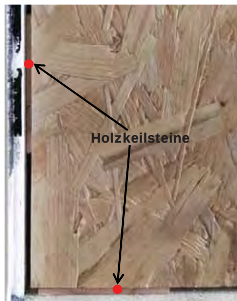
Abbildung 7: Ansicht der Holzkeile.
