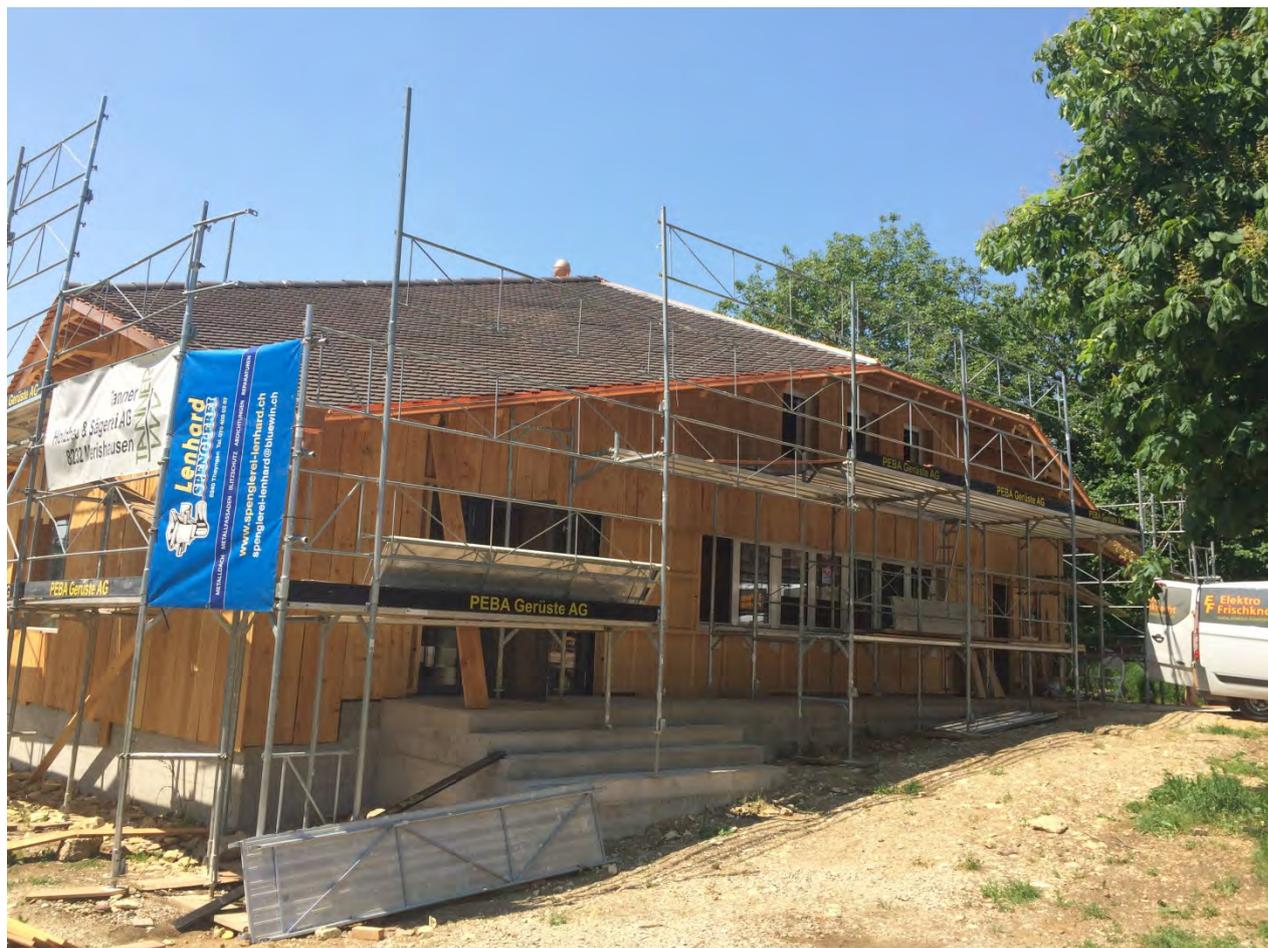
Alle tragenden Wände des Untergeschosses und Teile des Obergeschosses wurden aus kerngebohrtem Buchenrundholz gefertigt (Stand Mai 2017).
