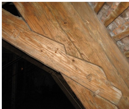
Abb. 2: Querblatt mit doppeltem Haken im Dachstuhl der Kirche Kaisten, CH, Quelle: BFH (2014)
