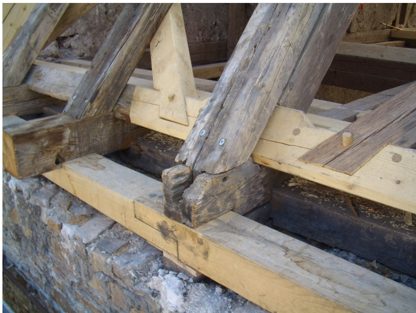
Abbildung 41: Ersatzbeuteile bei einer Dachstuhl-sanierung
