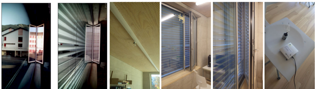
Figure 14 Ouverture mono-orientée sans et avec store et sondes de température et CO 2 à différents endroits du local
