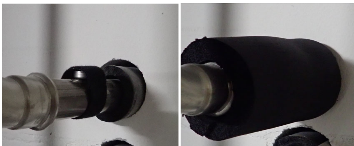
Abbildung 1: Fixierung und Wärmedämmung eines Temperaturfühlers an einem Leitungsabschnitt.
