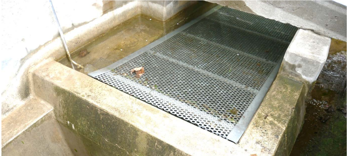
Abbildung 8: Lochblechrechen der Pilotanlage Obermühle
