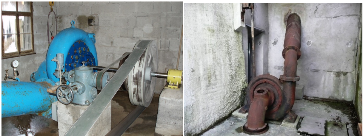
Abbildung 1: links - Francis-Spiralturbine mit ölhydraulischem Regler in einer Sägerei in Dietfurt/SG (24 kW); rechts - Francis-Spiralturbine (stillgelegt) in der Obermühle Andelfingen/ZH (5 kW). (Quelle: Hydro Engineering 2018)
