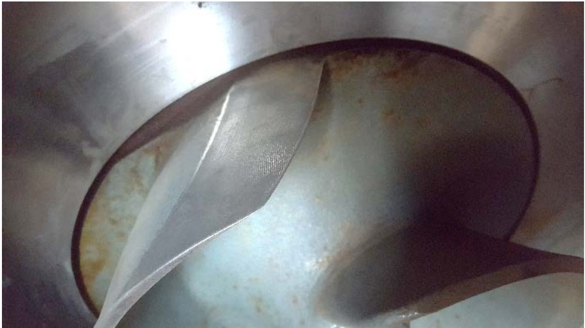
Abbildung 16: Original-Pumpenlaufrad mit bearbeiteter, spitz zulaufender Schaufelkante.
