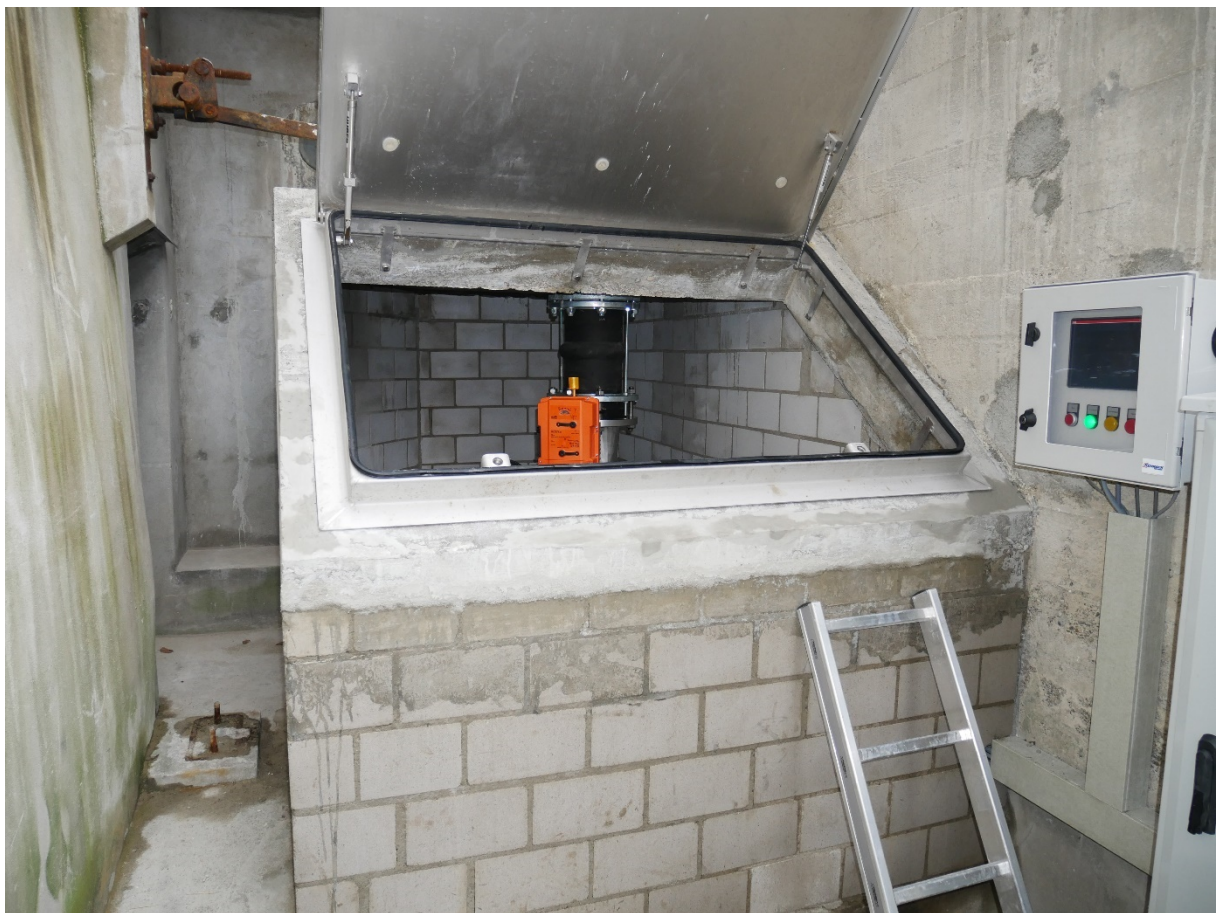
Abbildung 11: Turbinenschacht aus Kalksandstein mit Edelstahldeckel; Bedienpanel und Schaltschrank ausserhalb des Schachts.
