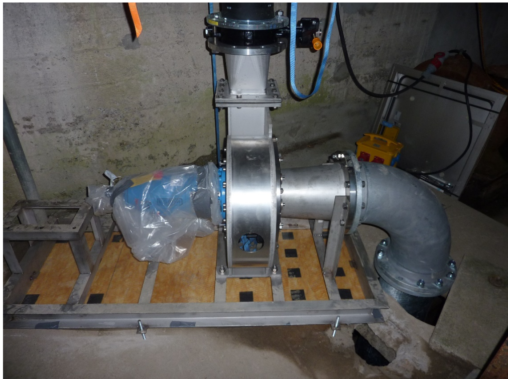
Abbildung 12: elastische Lagerung des Grundrahmens kurz vor dem Betonieren; die Hohlräume zwischen den MAFUND-Lagern wurden mit Glaswollmatten aufgefüllt, damit nur der Grundrahmen mit Beton verfüllt wird und die Lager ungehindert einfedern können und die Isolierwirkung erzeugen.
