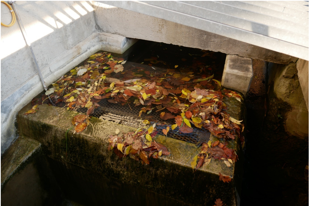
Abbildung 23: ungenügende Spülwirkung mit dem rampenförmig ausgeführten Lochblechrechen bei geringen Mülibach-Abflüssen (Quelle: Hydro Engineering 2020)
