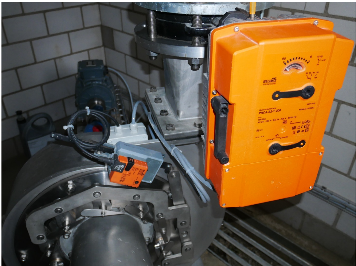
Abbildung 7: Linearantrieb für den Leitapparat und Drehantrieb für die Notschluss-Klappe (im Vordergrund)
