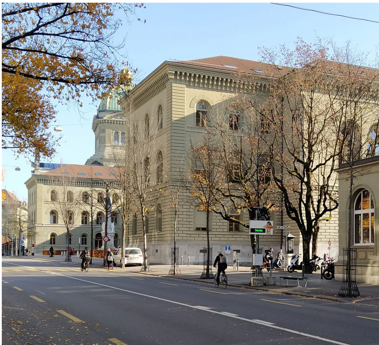
Abbildung 3: Foto mit Blick auf das Display und die Messstelle M2 (Aufn: Dominique Schneuwly, Bafu).
