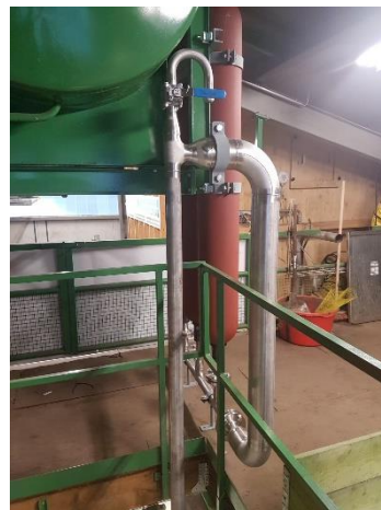
Abbildung 19: Einbau einer Syphonleitung
