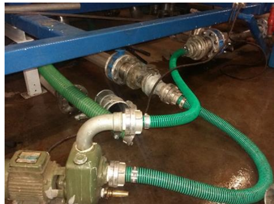
Abbildung 23: Spülleitungspumpe beim Eintrag
