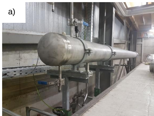
Abbildung 29: Neues, grösseres Expansionsgefäß für maximale Ausdehnung des Wassers. (a) Ansicht von der Seite; b) Ansicht von vorne)
