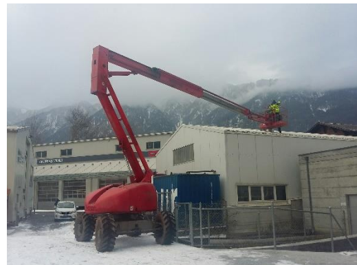
Abbildung 37: Messungen am Abgasrohr
