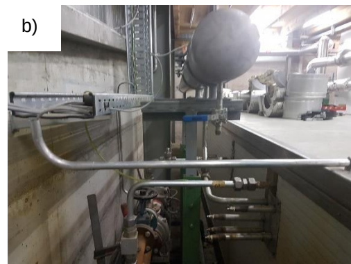
Abbildung 29: Neues, grösseres Expansionsgefäß für maximale Ausdehnung des Wassers. (a) Ansicht von der Seite; b) Ansicht von vorne)
