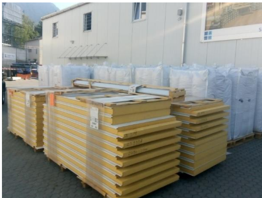
Abbildung 16: Aussenpaneelen und Schüttisolation
