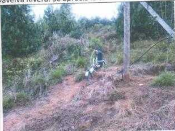
Bomba de agua
