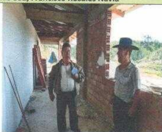
Interiores de la nueva planta en obra fina
