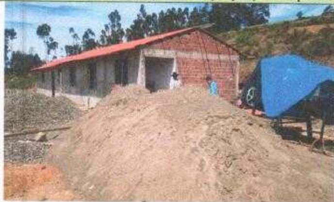
Vista panorámica de la planta en construcción
