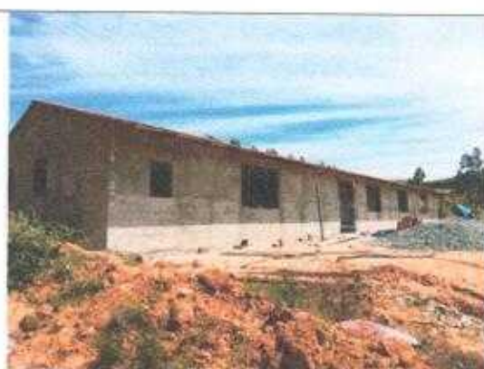
Planta propia en construcción
