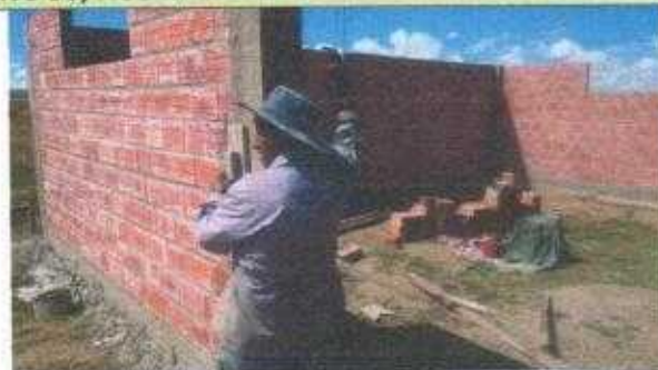
El albañil explicando el avance de la obra
