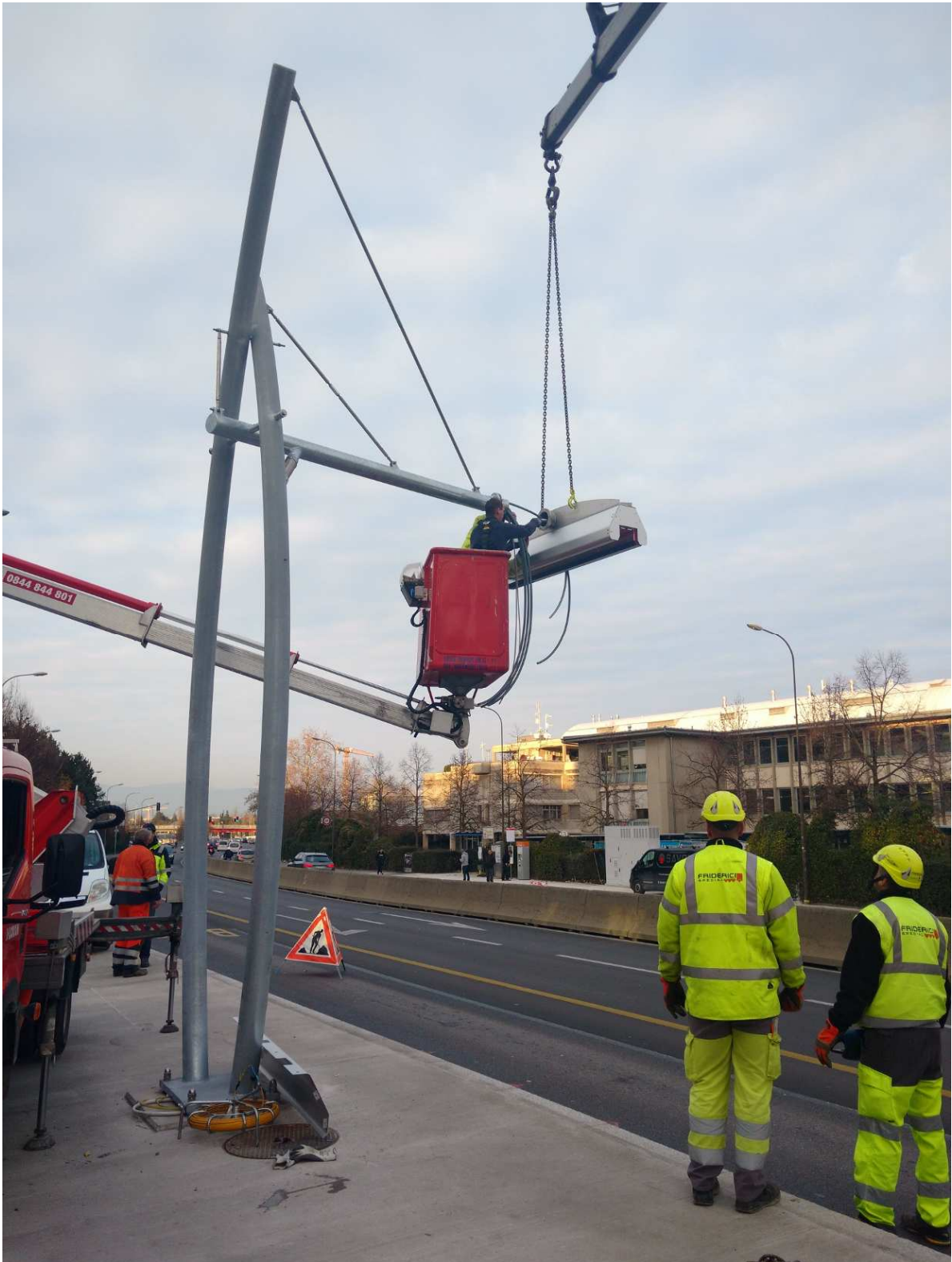
Figure 7 : Pose de la potence de recharge à l'arrêt Bossons, direction Carouge-Tours. Source : Nicolas SIMOND, 2017.
