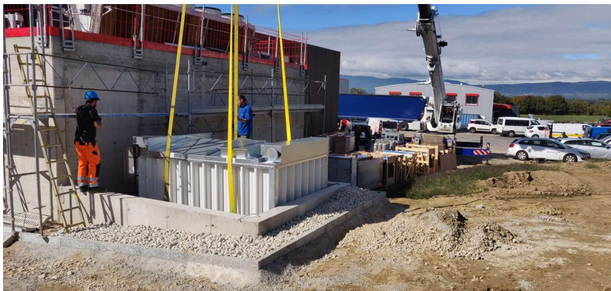
Abbildung 10: Installation des Eisspeichers
