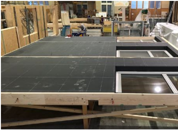
Abb. 21: Drei Holzfassadenelemente sind auf Böcke gelegt, bereit für Vormontage der Unterkonstruktion
