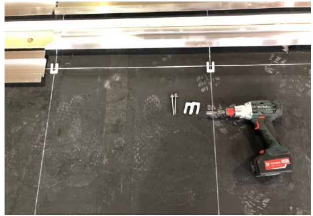
Abb. 22: Montage der horizontalen Hutprofile
