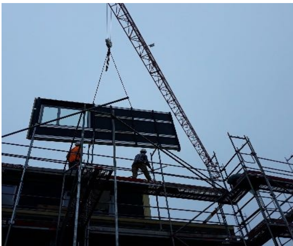
Abb. 28 bis 31: Montage der Holzfassaden-Elemente
