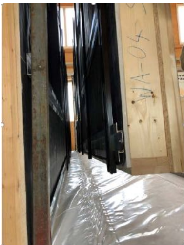
Abb. 25 bis 27: Beladen der Holzbau-Fassadenelementen auf das Transportgefährt.
