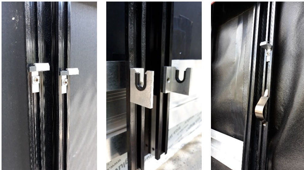
Abb. 37 bis 39: Einhängebeschläge oben, Drehpunkte unten sowie Feder zum Fixieren des PV-Fassadenmoduls.
