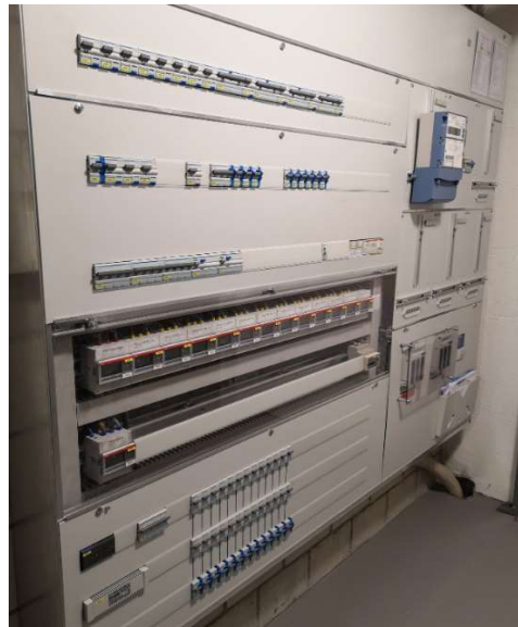
Abbildung 8: Links: Stiebel-Eltron Wärmepumpe für ein Gebäude und kontrollierte Lüftung (Hintergrund), Rechts: Installation der privaten Stromzähler für die einzelnen Wohnungen, Disporäume und Verbraucher (Quelle: Smart Energy Control)
