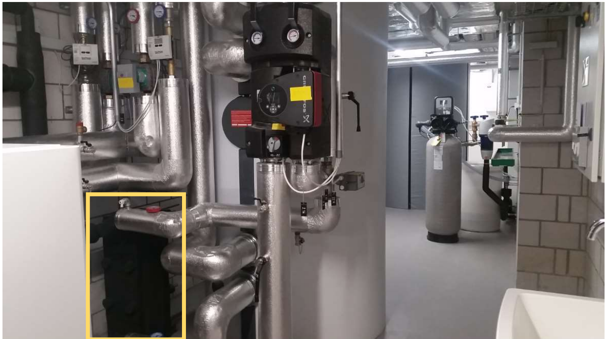
Abbildung 9: Vordergrund: Wärmepumpe mit Heizkreis und Wärmetauscher für «Natural Cooling» über Sonde (eingerahmt), Mitte: Pufferspeicher für Heizung, Hintergrund: Speicher für Brauchwarmwasser (Quelle: Smart Energy Control)
