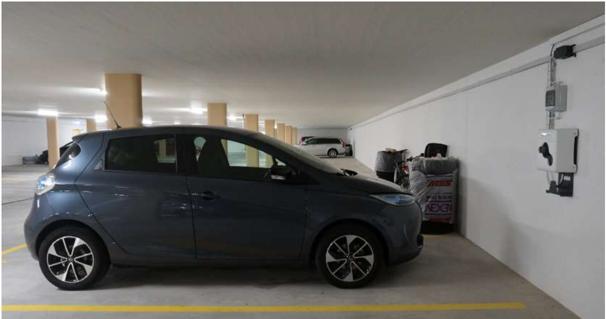
Abbildung 10: Elektromobil in Tiefgarage mit steuerbarer Ladebox 4..22kW (rechts), Flachbandkabel mit Piercing-System (oben rechts) (Quelle: Smart Energy Control)
