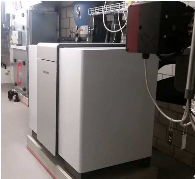
Abbildung 8: Links: Stiebel-Eltron Wärmepumpe für ein Gebäude und kontrollierte Lüftung (Hintergrund), Rechts: Installation der privaten Stromzähler für die einzelnen Wohnungen, Disporäume und Verbraucher (Quelle: Smart Energy Control)
