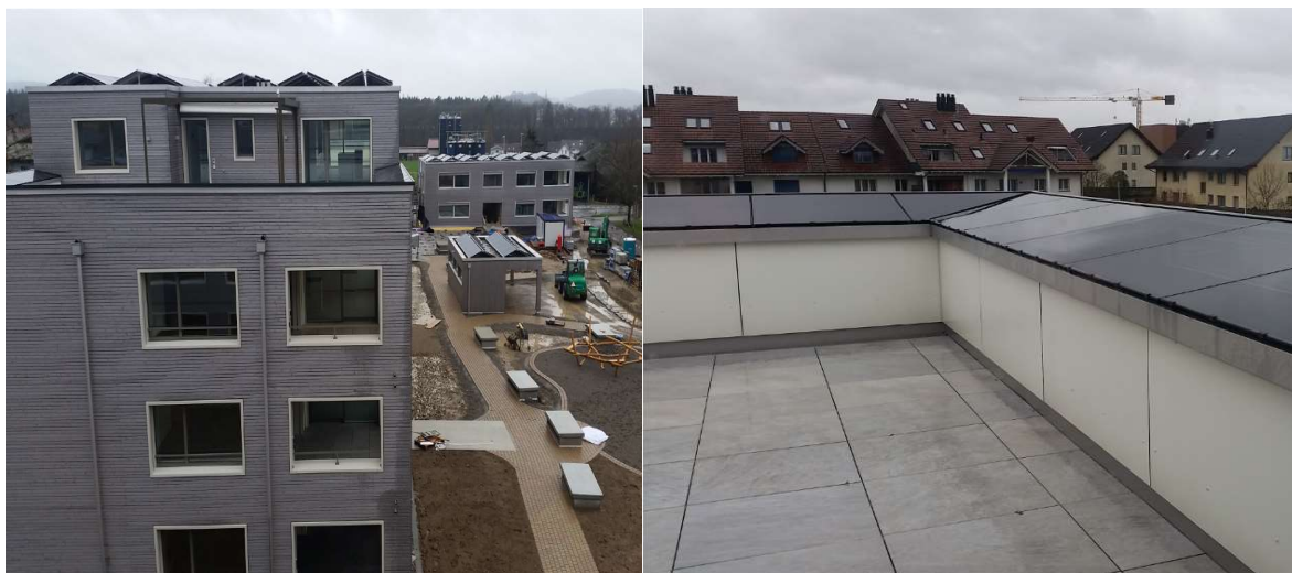
Abbildung 3: Links: Blick auf Dächer mit PV-Anlagen (Bauphase), Rechts: Solaranlagen auf Brüstungen der Dachterrassen (Quelle: Setz Architektur AG)
