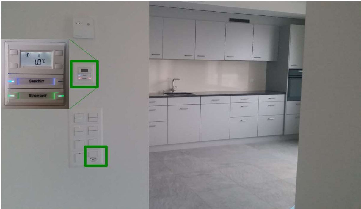
Abbildung 5: Ausrüstung der Wohnungen mit KNX: Temperaturüberwachung, Solarbetrieb für Geschirrspüler, Anzeige Stromtarif, Solarsteckdose (Quelle: Smart Energy Control)
