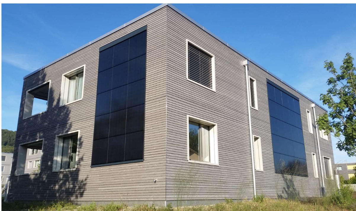
Abbildung 4: PV-Fassadenmodule (Quelle: Setz Architektur AG)
