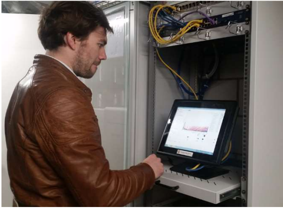
Abbildung 7: Industrie-PC mit Eigenverbrauchsmanager-Software zur Steuerung aller Verbraucher in einem Gebäude (Quelle: Smart Energy Control)
