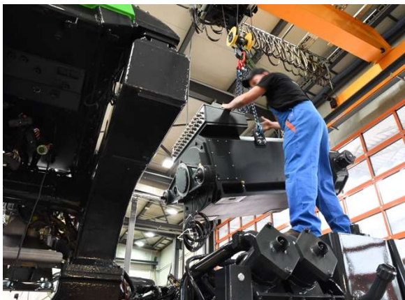
Einbau Synchron-Motor von Oswald
