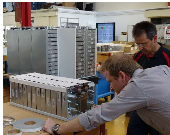
Montage Batteriestack (16 Batteriestacks pro Batterie) bei der Schaltag AG
