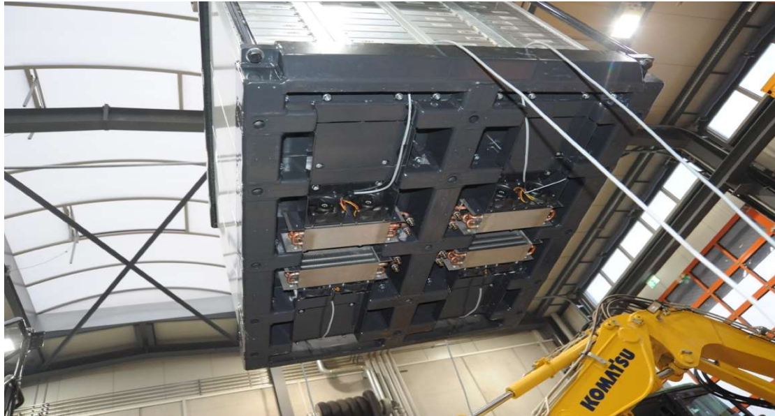
Vor dem Einbau sind die je 2x4 Hochleistungslüfter und die Wärmetauscher sichtbar
