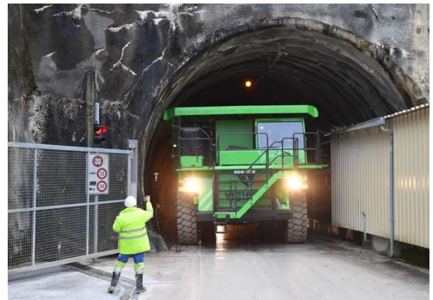
Maximale Ausnutzung des Tunnelprofils
