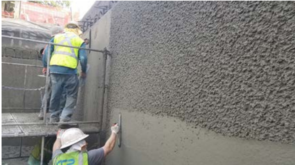
Abbildung 14: Abtalschieren des frischen Spritzbeton.
