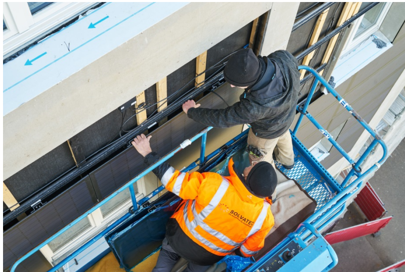
Abbildung 6: Montage der PV-Module an der Nordfassade, Februar 2015 (Quelle: Martin Zeller).
