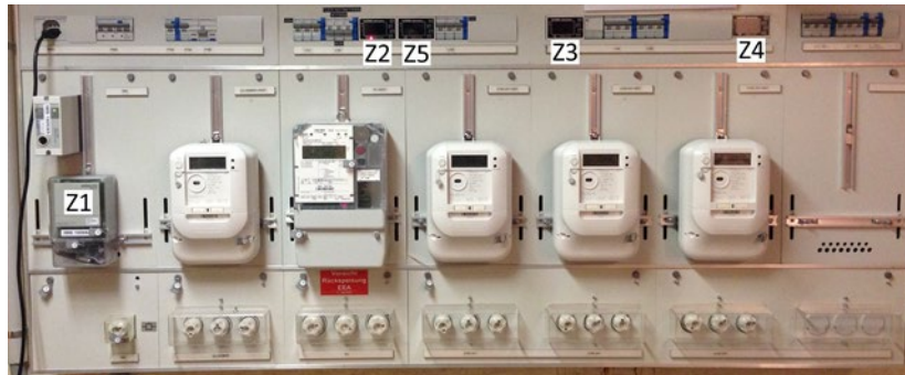
Abbildung 23: Modbus Stromzähler Z2 bis Z5 für die Erfassung der Energie- und Leistungsdaten. (Quelle: Fabio Rui)
