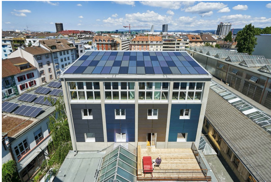
Abbildung 10: Ansicht Südfassade und Dachanlage, Stand 2015 (Quelle: Martin Zeller).
