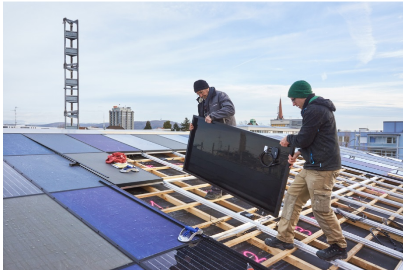
Abbildung 8: Montage der dachintegrierten PV-Anlage im Februar 2015, Unterkonstruktion System Mecosun (Quelle: Martin Zeller).
