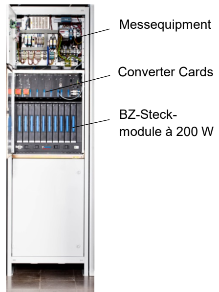
Bild 3: BZ-Rack mit geöffneter Tür, Foto: Benning Schweiz
