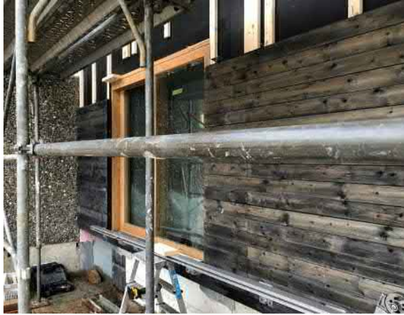
Abbildung 31: Eichenfenster mit druckimprägnierter Holzschalung (Eiche, Messing, Nuss)
