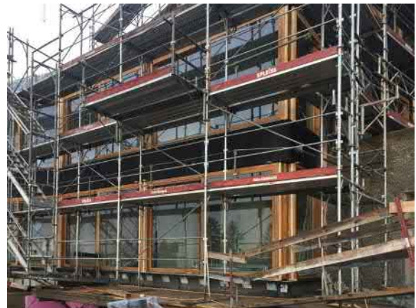
Abbildung 40: Fertig montierte Vakuumfenster
