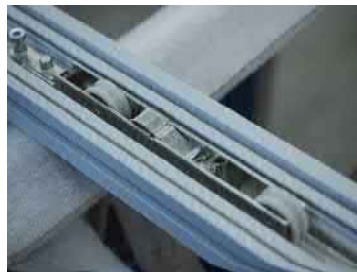
Abbildung 58: versenkter Laufwagen
