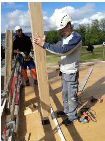
Abbildung 26: Setzen der Holzstützen
