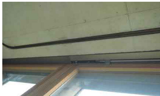
Abbildung 12: Versenkung der Motoren durch Aussparungen in der Betondecke
