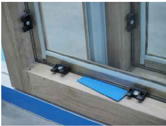
Abbildung 9: Fixation des Vakuumglases am Grundes des Glasfalzes
