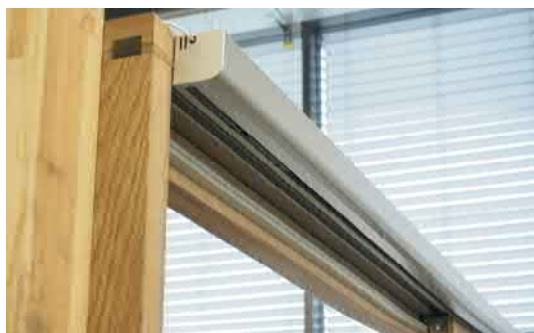
Abbildung 11: Motoraufsatz an Schiebefenster
