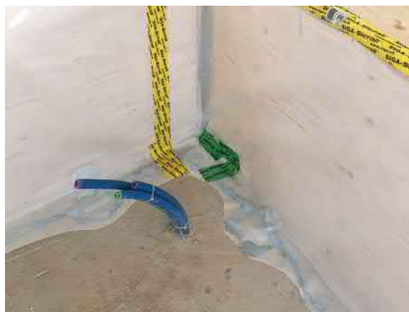
Abbildung 42: Vorbereitungen für Bodensteckdose
