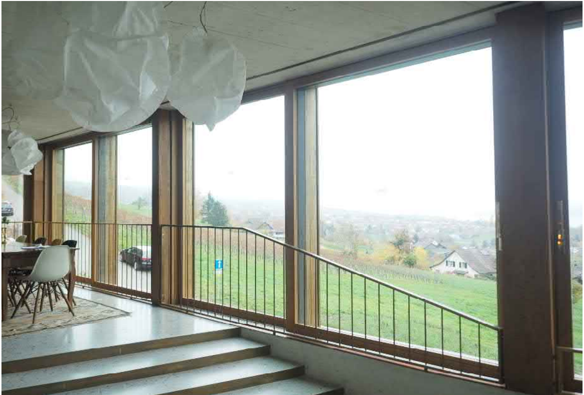
Abbildung 51: in «grossen» Schiebefenstern sollte VIG weich eingebaut werden.
