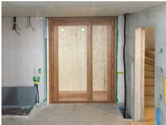
Abbildung 39: Eingangstüre mit provisorischer Holzplatte bis nächste Glaslieferung eintrifft.
